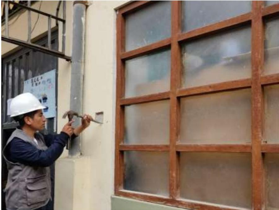
**Fotografía N° 14.** Retirando el recubrimiento en uno de los elementos estructurales (columna) para la posterior prueba de esclerometría.
