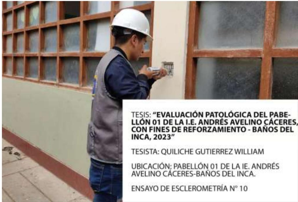
**Fotografía N° 20.** Realizando el ensayo de esclerometría en una de las columnas del primer piso.
