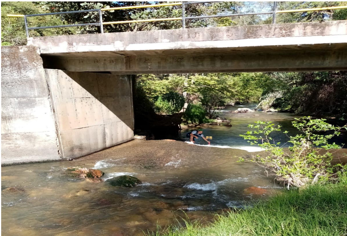
Figura N°66: Medición de la Socavación Local aguas abajo del puente empleando un equipo topográfico
