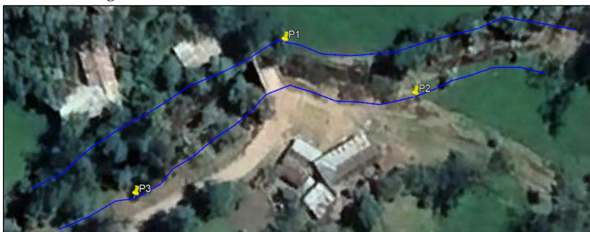
Figura N°24: Huellas de Inundación -Tramo Puente Yaminchad
