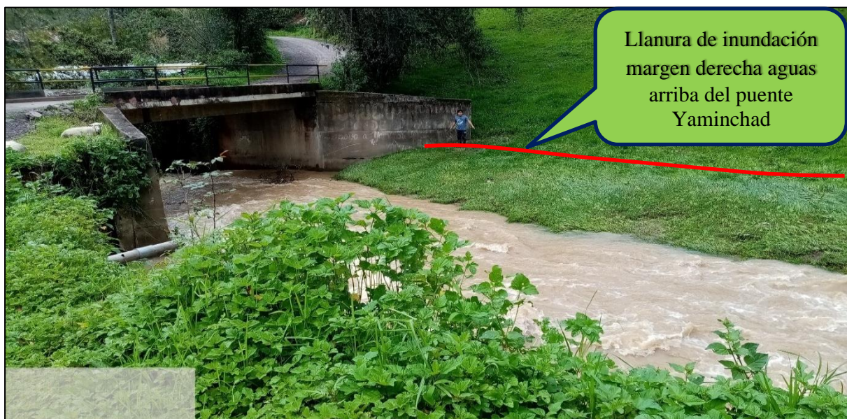
Figura N°41: Llanura de Inundación Margen Derecha Aguas Arriba Puente Yaminchad
