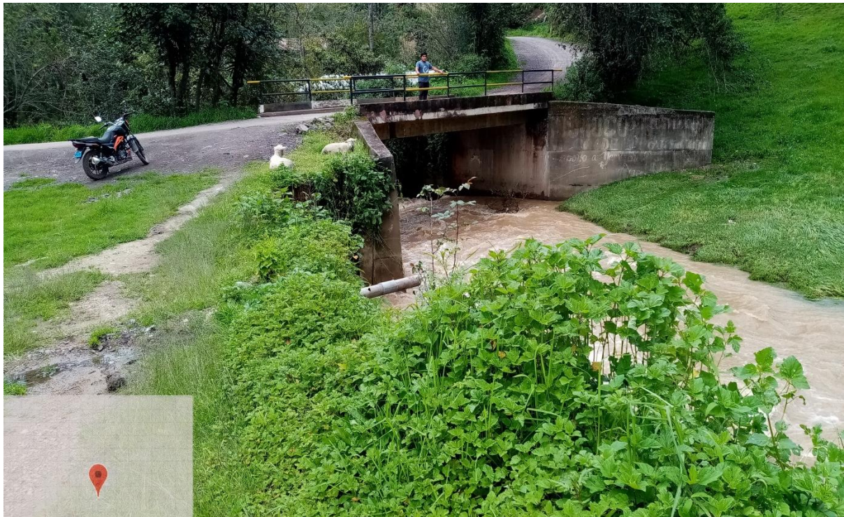
Figura N°63: Vista panorámica del puente Yaminchad
