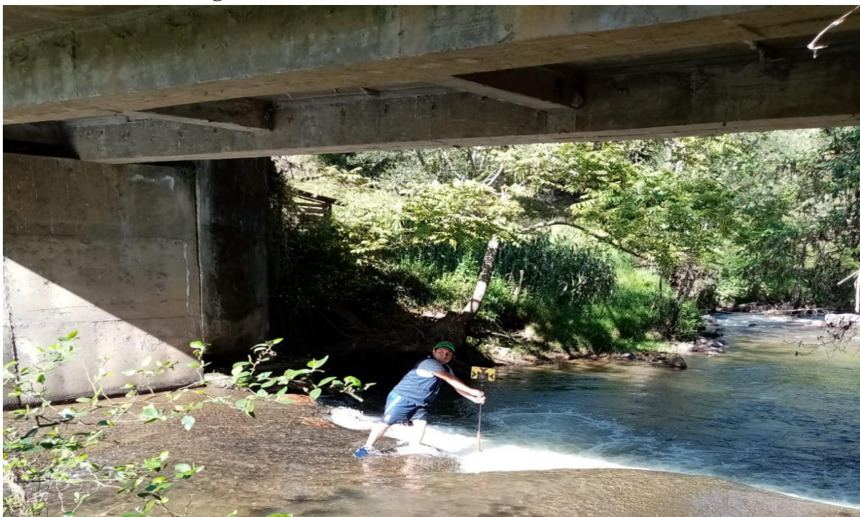
Figura N°25: Medición Socavación Local Existente
