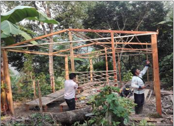
Foto 3. Instalación del vivero
