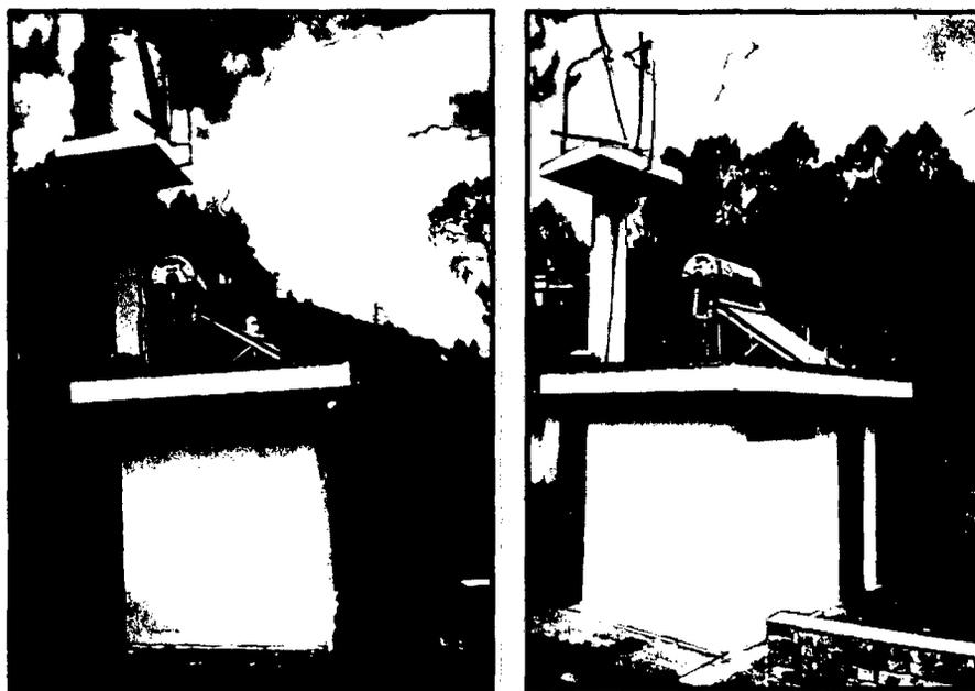
Foto 1. Unidad básica de saneamiento de tipo arrastre hidráulico característica en la comunidad de Quinamay alto. El cuarto de baño está construida con cimientos, columnas de concreto armado, muros de ladrillo y losa aligerada.
