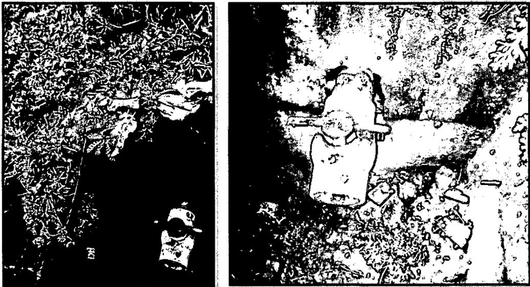
Foto 8. Válvula de extracción de lodos instalada al lado del biodigestor, en una caja de concreto en buen estado con tapa del mismo material.
