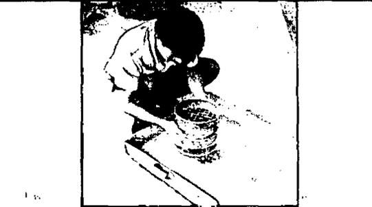
IMAGEN N° 31. Tamizado del agregado grueso luego del ensayo de Abrasión
