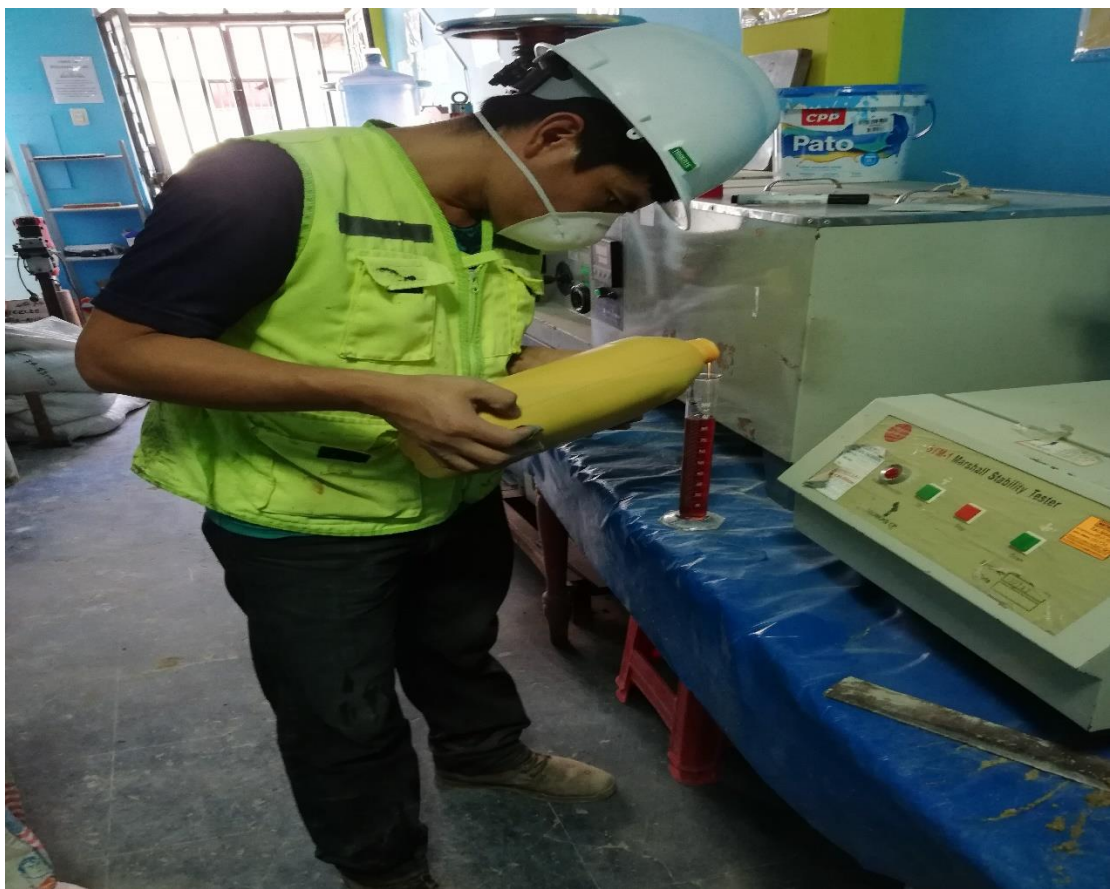
Imagen N° 8: Medida del aditivo superplastificante.
