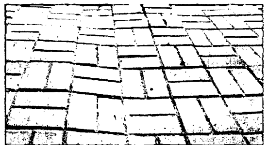
Imagen 16. Hundimiento
