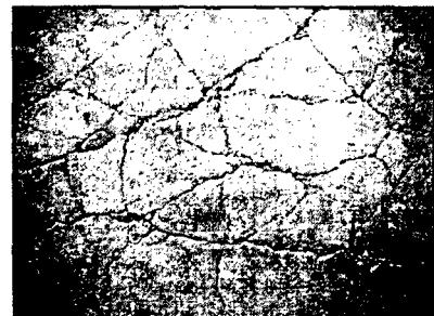
Imagen 14. Fisuramiento por retracción
