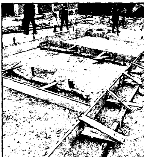
Imagen 45. Encofrado para losas de pavimento rigido de 3.20 m x 4 m del Jr. San Martín Cda. 9 de la ciudad de Chota - Cajamarca
