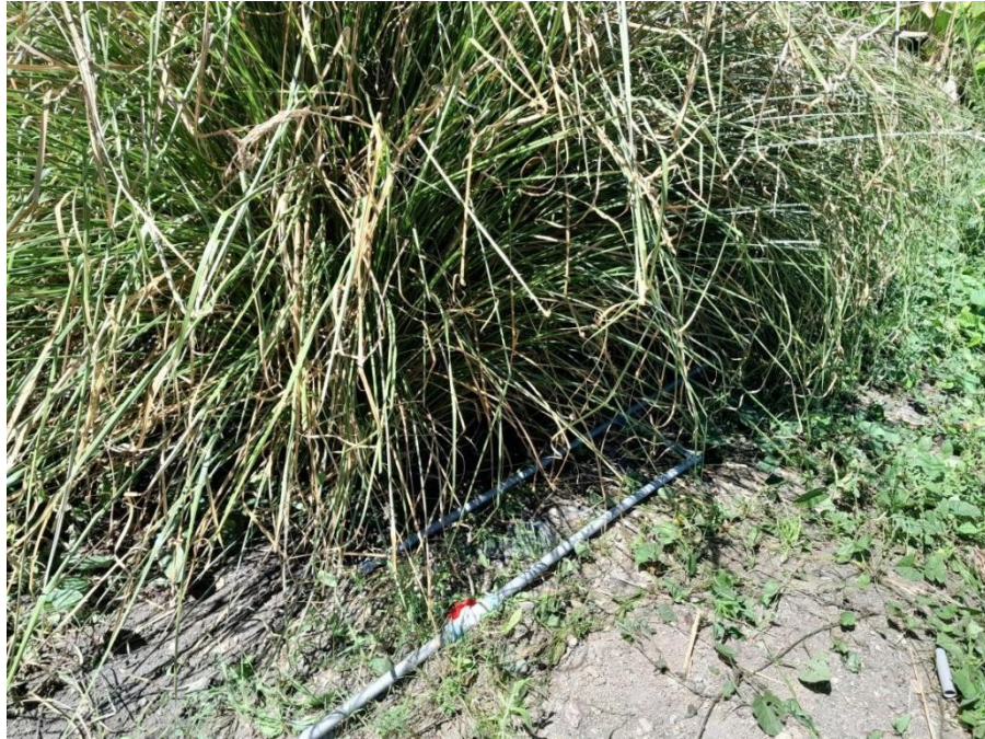
FOTO N° 8: Vista del ingreso del agua residual al humedal
