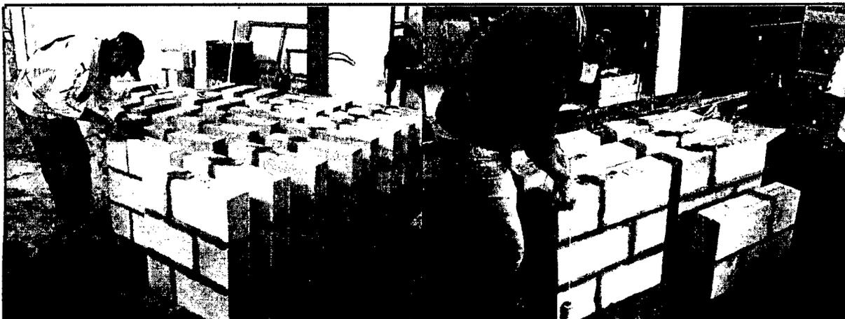
*Imagen N° 36: En las imágenes se observa la construcción de los muretes y pilas, así como la verificación de la verticalidad con la plomada.*
