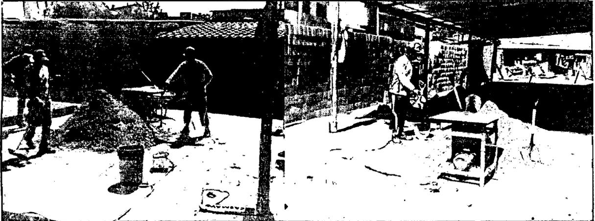
*Imagen N° 24: En la imagen se observa la visita a la fábrica, así como la dosificación de materiales para la elaboración de los bloques huecos de concreto.*
