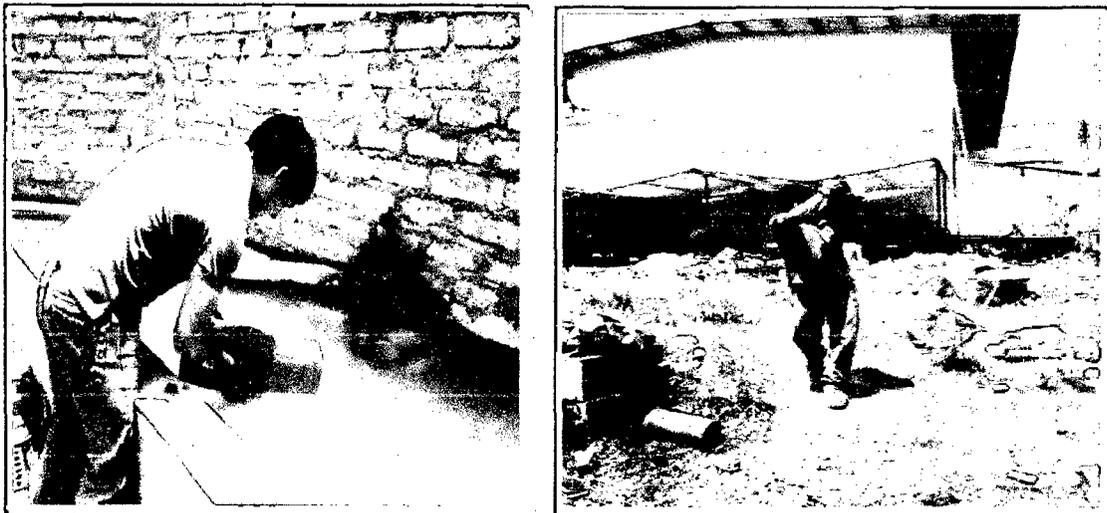
*Ilustración 18. Se realizó el curado en una poza habilitada para este propósito, así se tuvieron sumergidas durante 28 días por conveniencia y para la veracidad de los resultados.*
