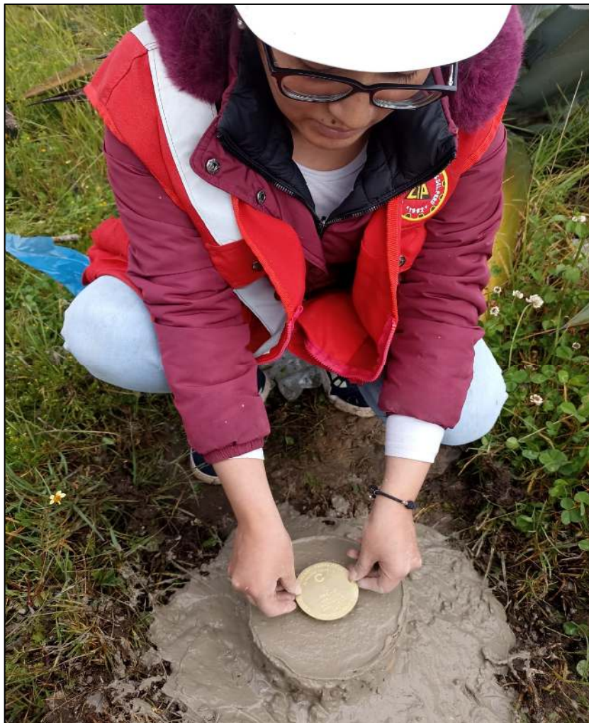
Fotografía N° 01: Monumentación de Puntos Geodésicos Punto "PPC – C" de Orden C
