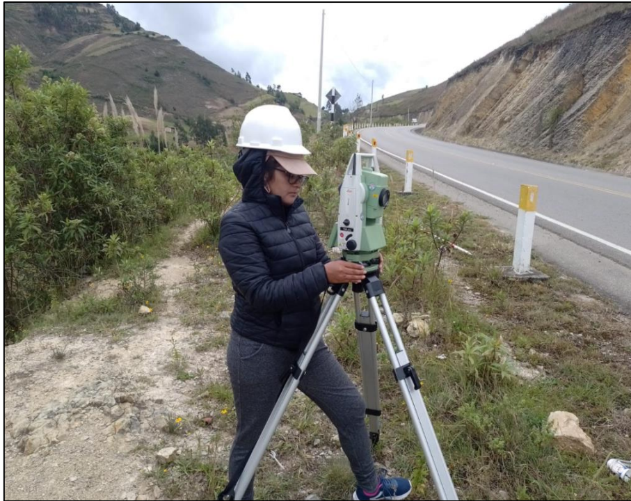
Fotografía 10: Levantamiento topográfico a la altura del Km. 12 de la carretera Puyllucana – Pampa de La Culebra
