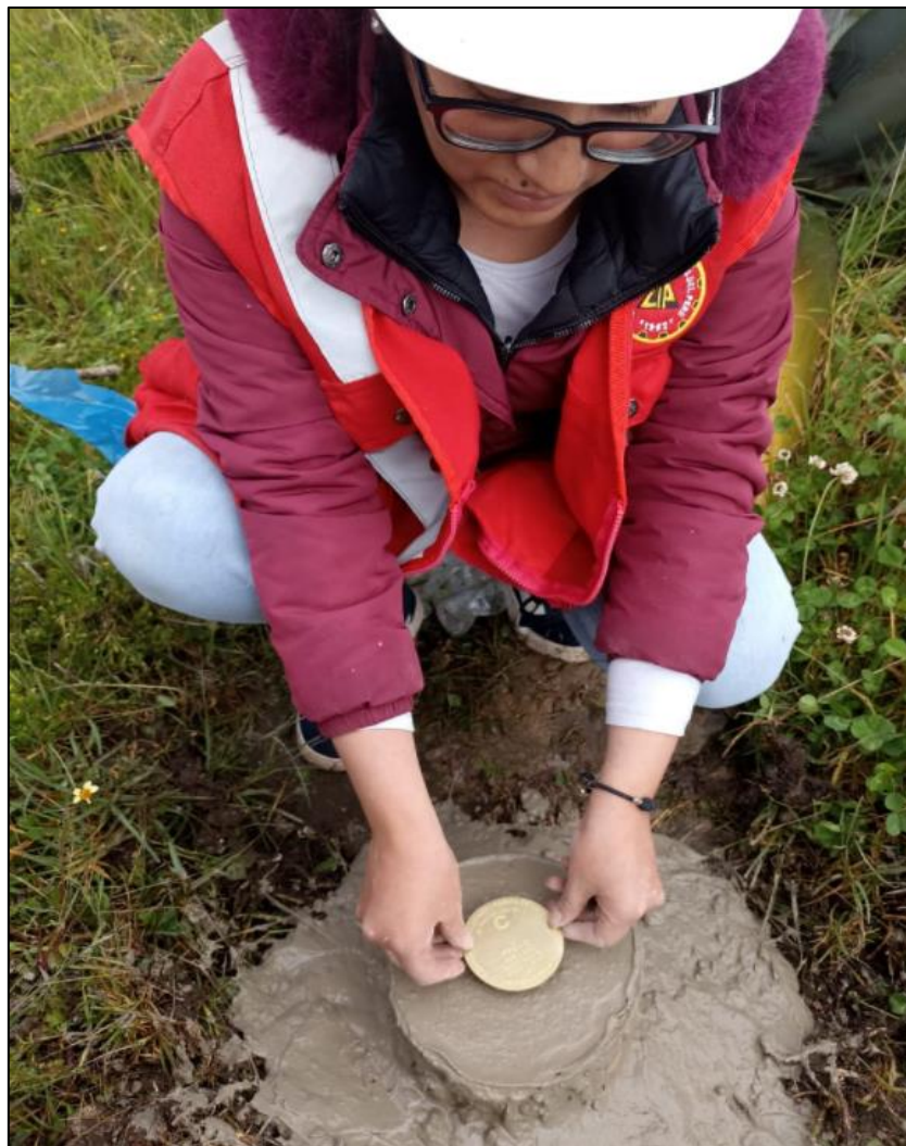
Fotografía 02: Colocación de la placa “PPC - C” a la altura del Km. 18 de la carretera Puyllucana – Pampa de La Culebra.
