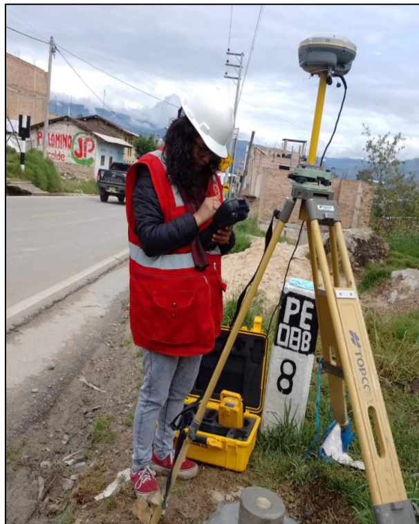
Fotografía 06: Recepción de puntos en el Punto estático “PPC - A”
