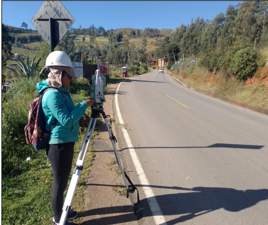
Fotografía 11: Levantamiento topográfico a la altura del Km. 09 de la carretera Puyllucana – Pampa de La Culebra
