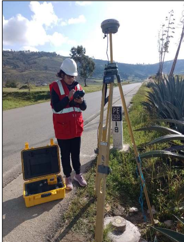
Fotografía N° 03: Lectura y posicionamiento de Punto Geodésico "PPC - C"
