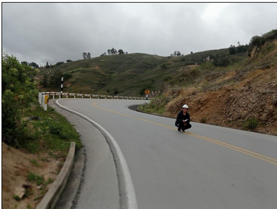
Fotografía 13: Medición de peraltes con eclímetro a l altura del Km. 15 de la carretera Puyllucana – Pampa de La Culebra
