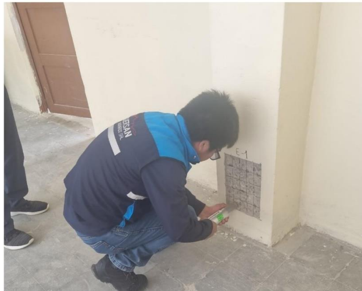
FOTOGRAFÍA N°1: Ensayo 1, PABELLÓN B - COLUMNA N° 01: Eje 4-4 y Eje A-A
