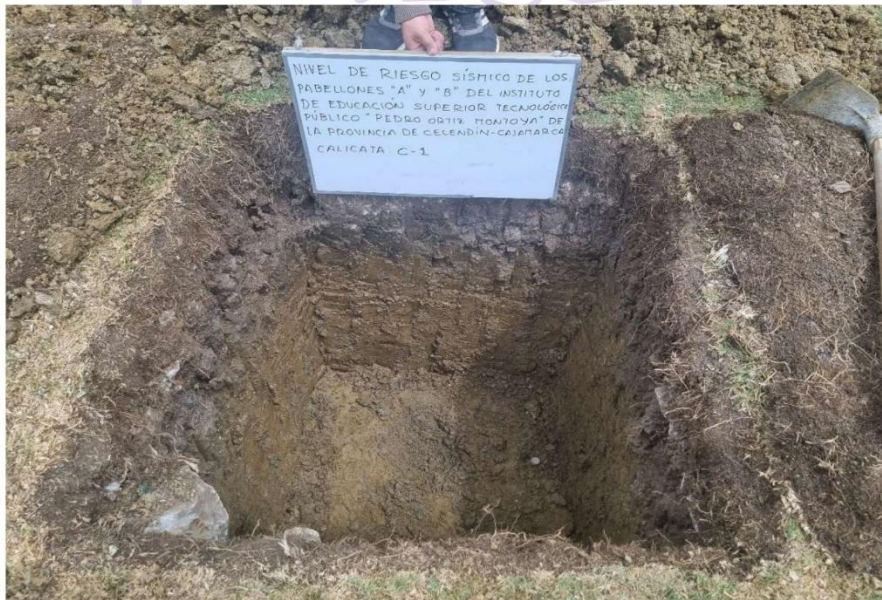
FOTOGRAFÍA N° 02: Vista de perfil estratigráfico de la calicata C-1.
