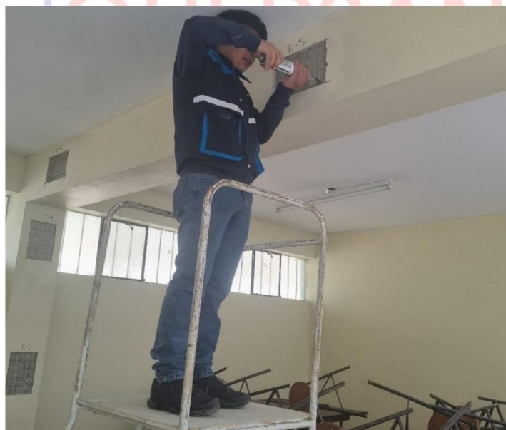
FOTOGRAFÍA N°2: Ensayo 5, PABELLÓN B - VIGA N° 01: Eje 4-4, entre Eje A-A y Eje B-B
