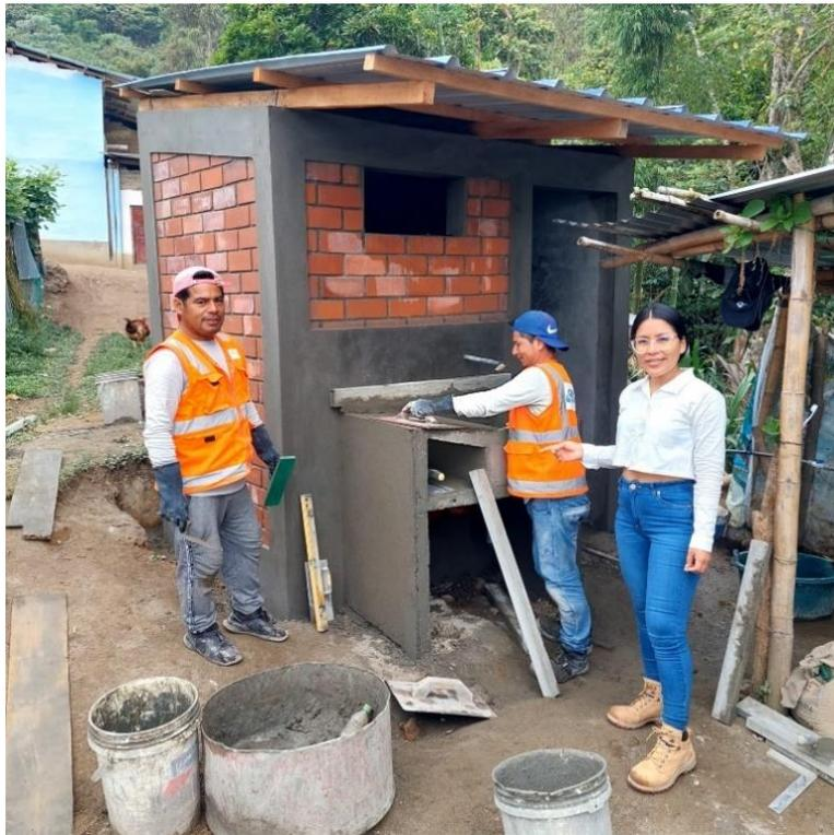
**Figura N° 15 :** Verificando el avance de los muros de ladrillo, en caseta UBS.
