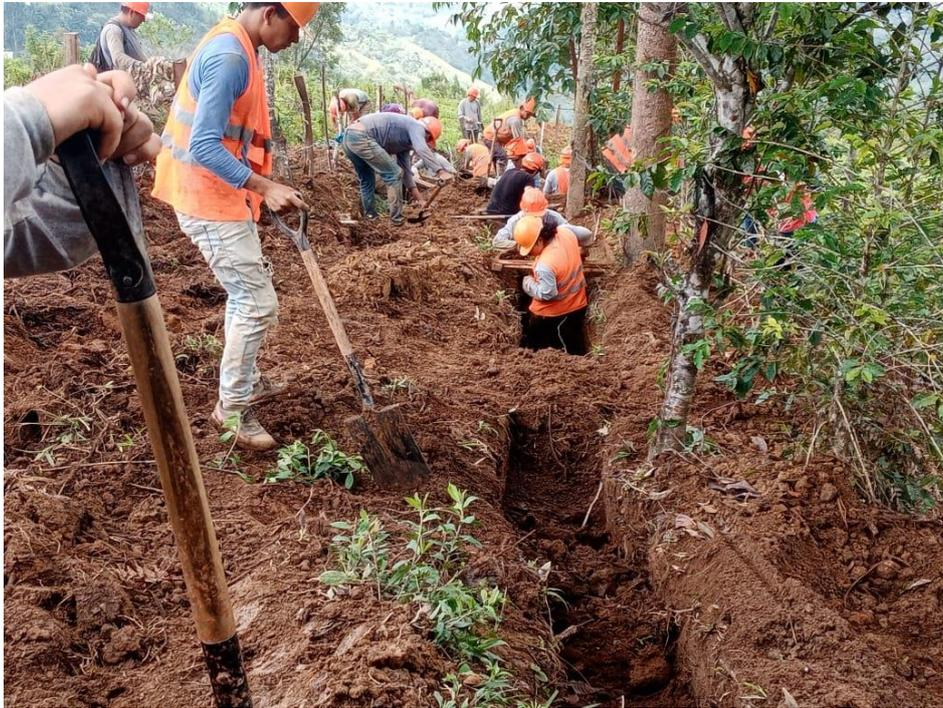
**Figura N° 11**: Verificación de profundidad de excavación manual para redes de distribución de agua.
