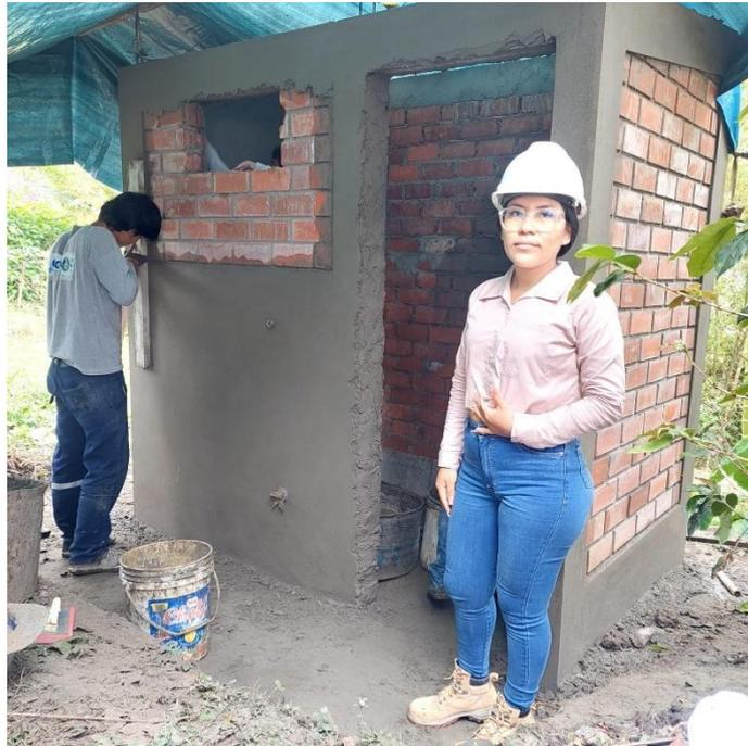
**Figura N° 13 :** Asentado de ladrillo en caseta UBS.
