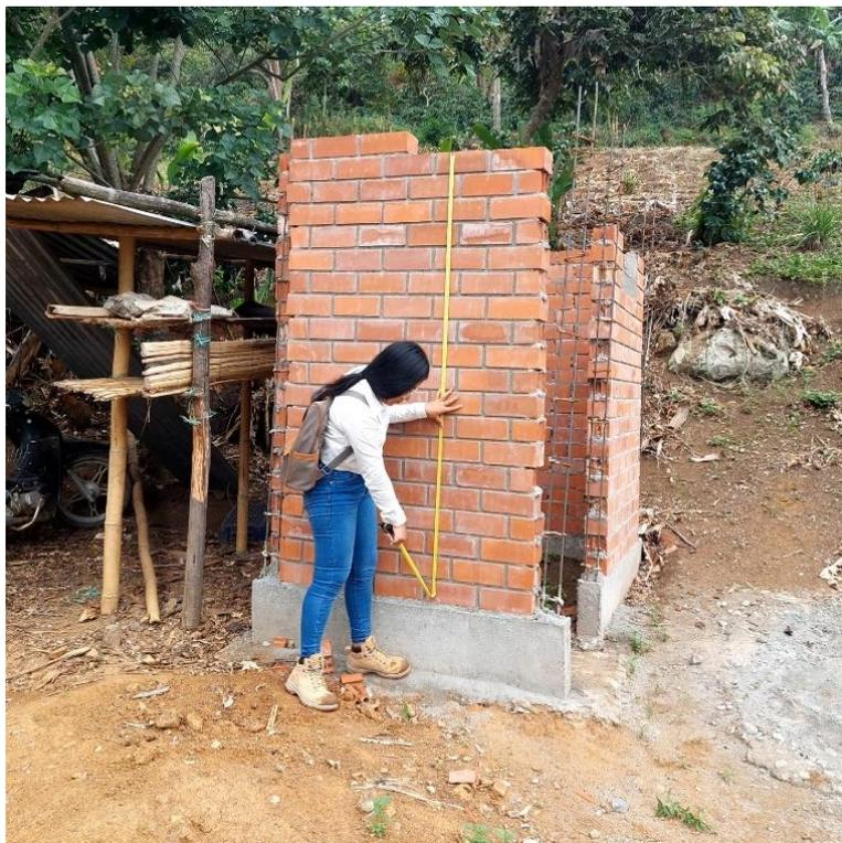
**Figura N° 16 :** Muro de ladrillo sólido de concreto en pozo de absorción.
