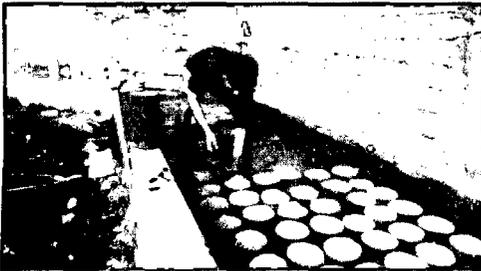
**IMAGEN N°30:** Sacando las probetas después de un curado de 28 días de curado.
