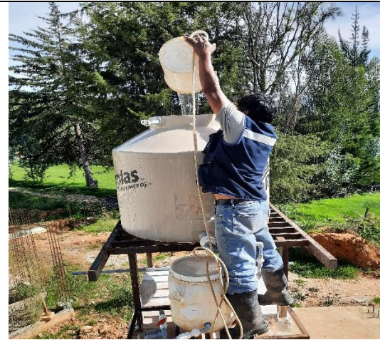
Fotografía N° 06: Cloración del agua
