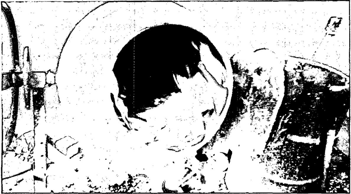
*Imagen Nº 57: Mezclado de los componentes del Concreto Celular*
