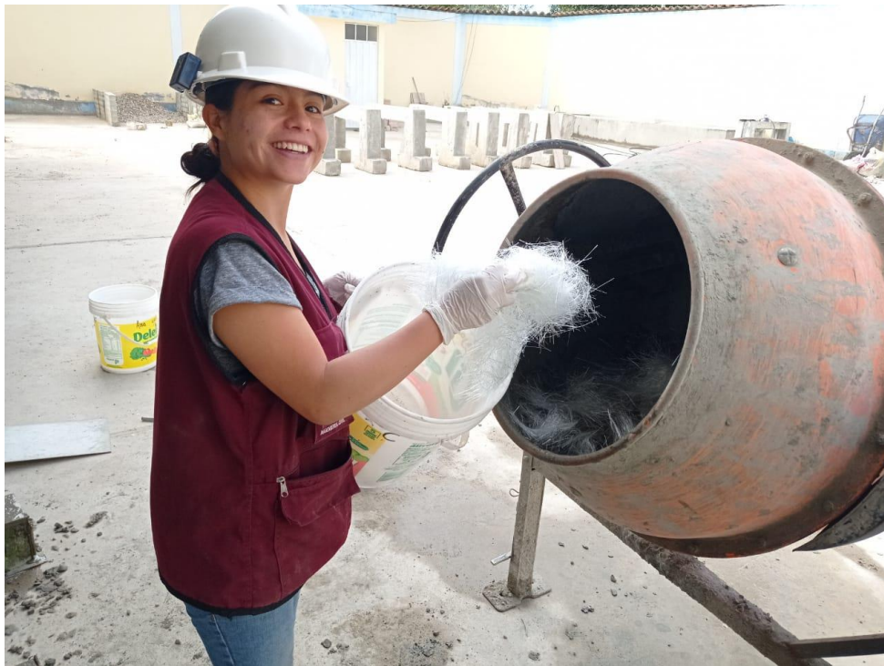
Figura 18: Incorporación de fibra de vidrio en la mezcla de concreto
