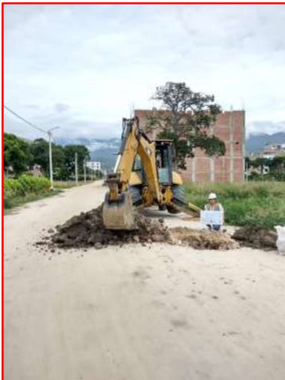
Figura 74. Excavación de calicata C-3, h=2.00m Calle Isaac Newton #8.
