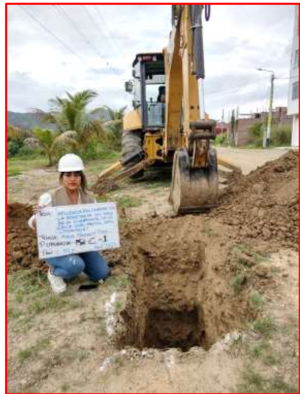
Figura 71. Excavación de calicata C-1, h=2.00m
