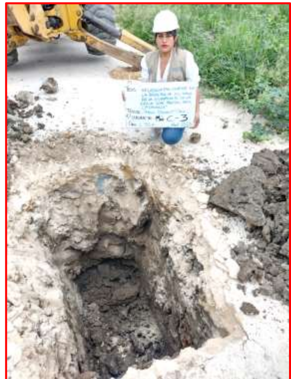
Figura 75. Profundidad de excavación h=2.00m.
