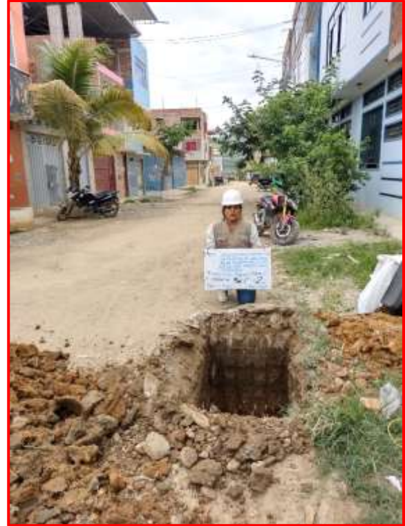
Figura 73. Excavación de calicata C-2, h=2.00m
