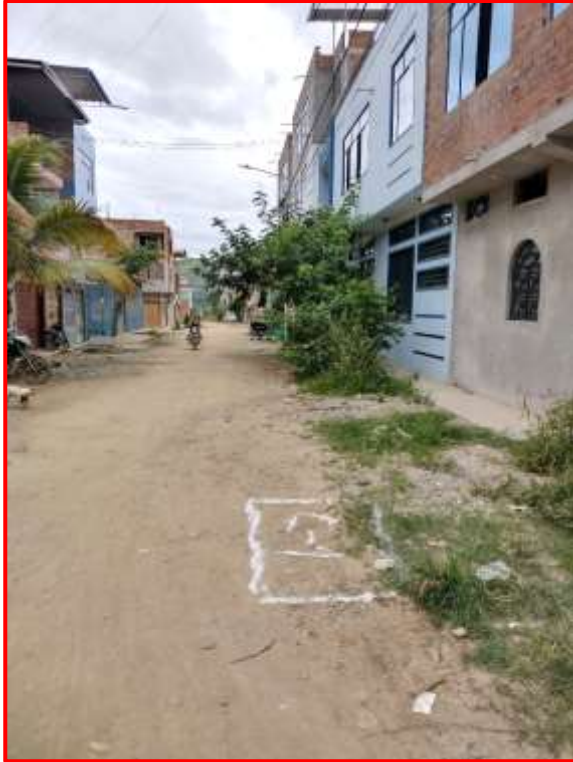
Figura 72. Replanteo de calicata en calle Isaac Newton #04.
