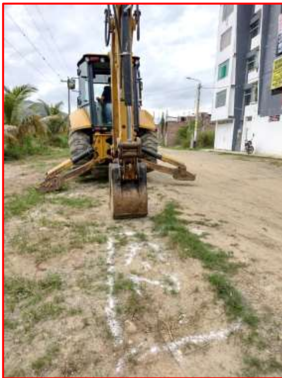
Figura 70. Replanteo de calicata en calle Isaac Newton #01.
