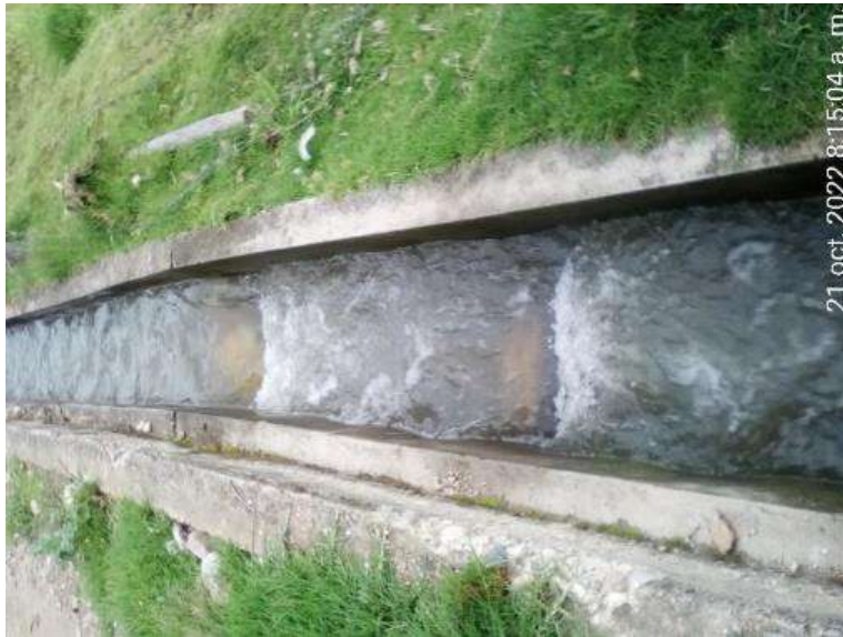
HG, 21 de octubre, días de lluvias, rama del canal de riego
