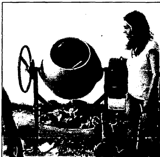
Fig. 3.20. Elaboración de una tanda de concreto
