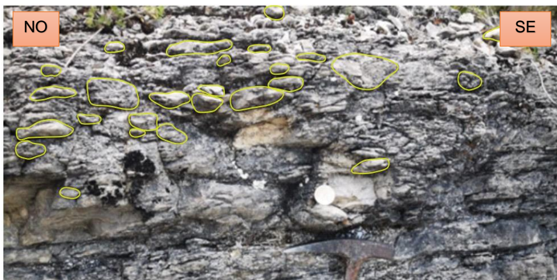
Figura 33. Estructuras nodulosas producidas por la erosión de las calizas arcillosas, con coordenadas E: 815211, N: 9241476.
