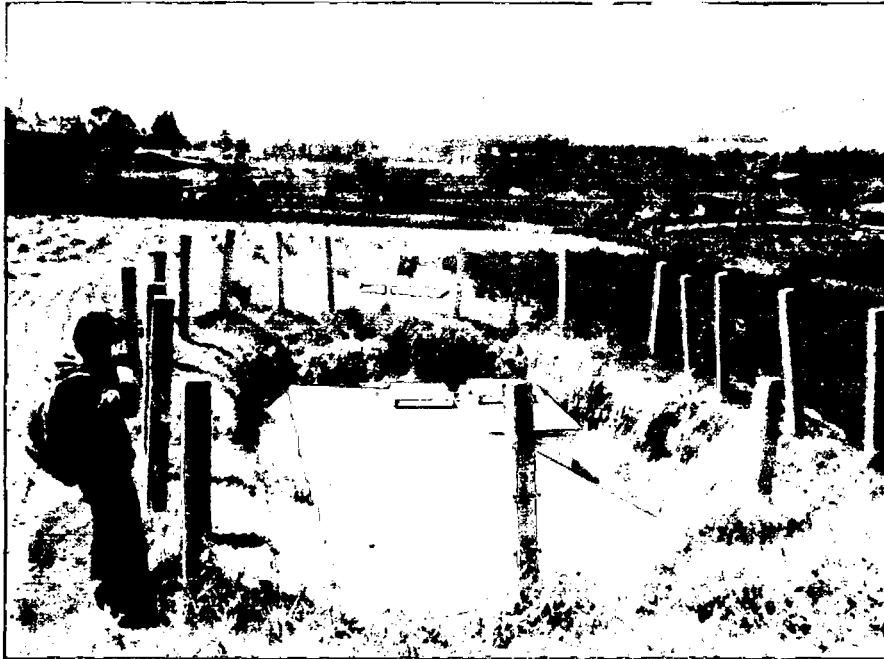
Foto 09. La imagen muestra la captación existente que abastece de agua al caserío de Yanamarca – Sector Ingapila.
