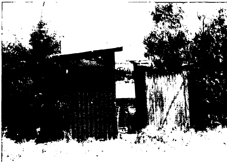
Foto 15. La imagen muestra el estado actual de las letrinas sanitarias y su mala ubicación con respecto a las viviendas.
