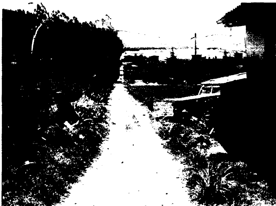
Foto 04. La imagen muestra una trocha carrozable por donde se construirá un ramal de la nueva red de distribución.
