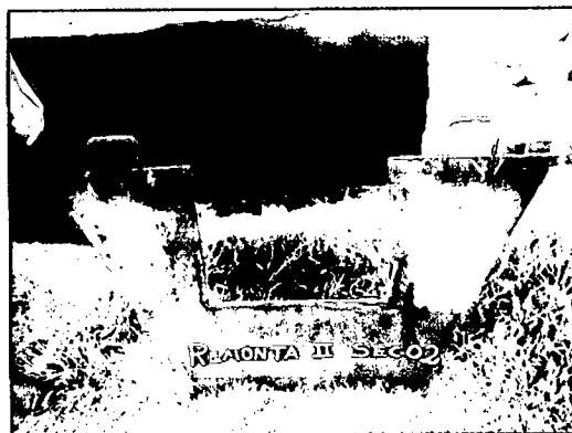
Fotografía 05. Equipo de aforo-vertedor rectangular para sección final
