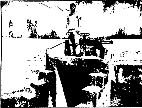
Fotografía 01. Bocatoma- inicio del canal Remonta II
