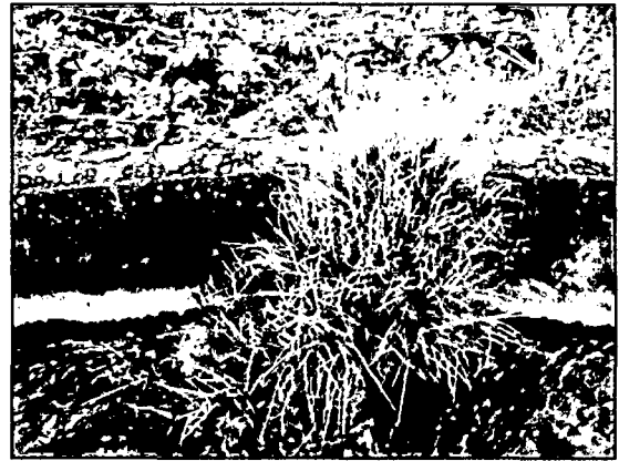
Fotografía 20. Presencia de grama y pasto en las juntas
