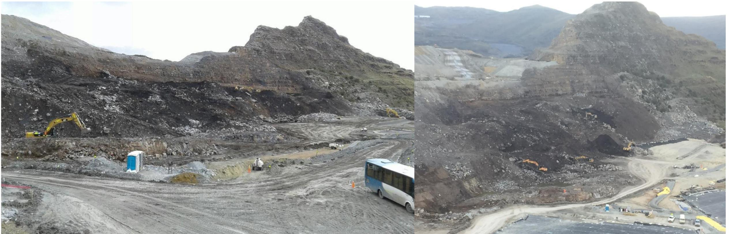
Figura 124 Limpieza de fundación masiva en talud
