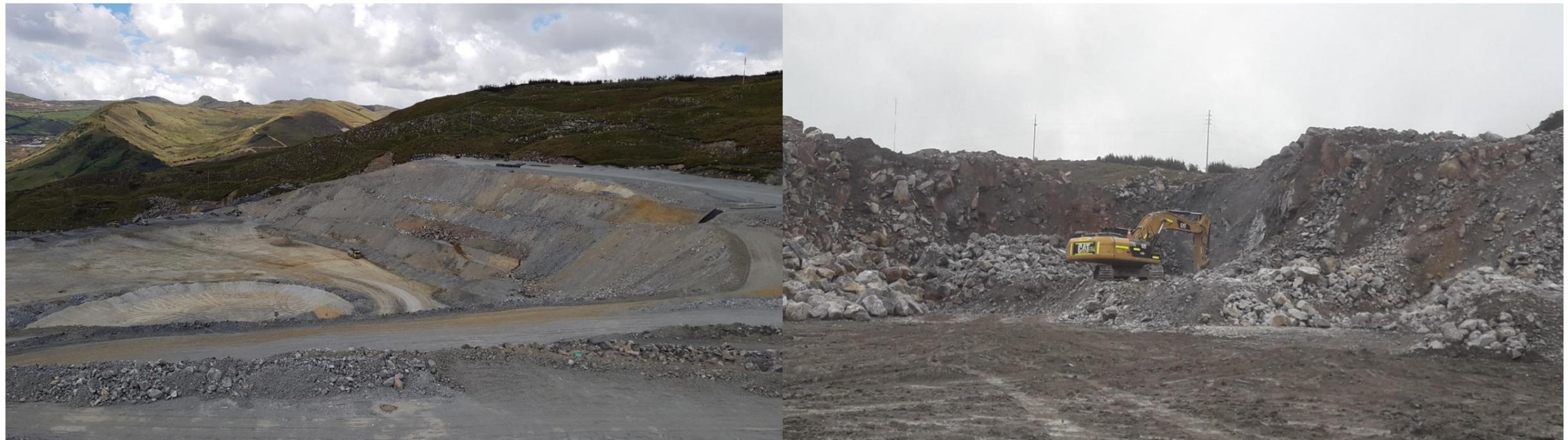
Figura 104 Relleno y limpieza de material en zonas de contacto
