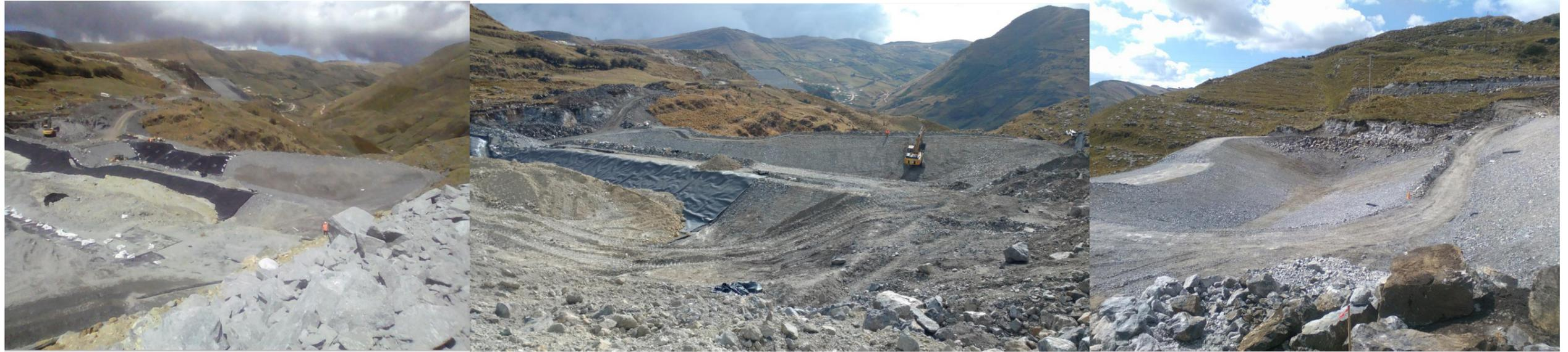
Figura 129 Nivelación y revestimientos en la poza de sedimentación
