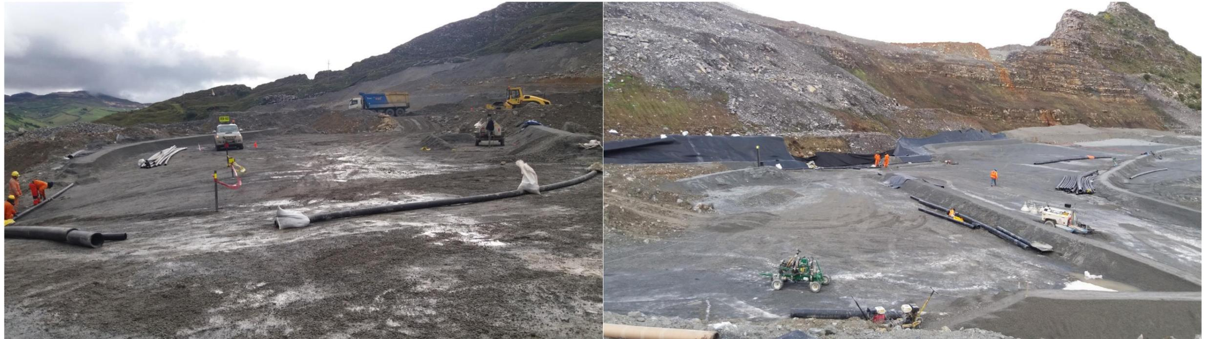
Figura 114 Conexión del sistema de drenaje y rellenos posterior
