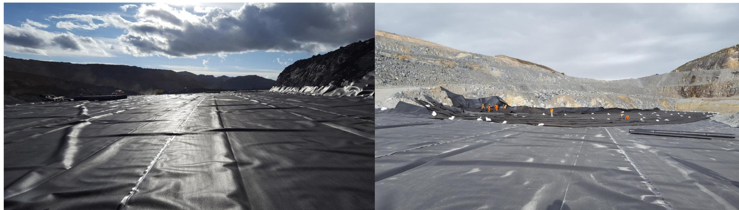
Figura 111 Revestimiento de Shingles con geomembrana y geocompuesto
