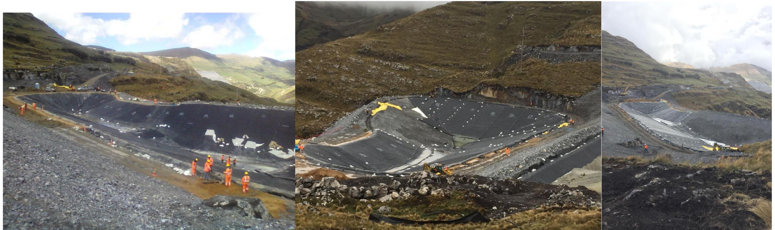
Figura 130 Trabajos de revestimientos en la poza de sedimentación
