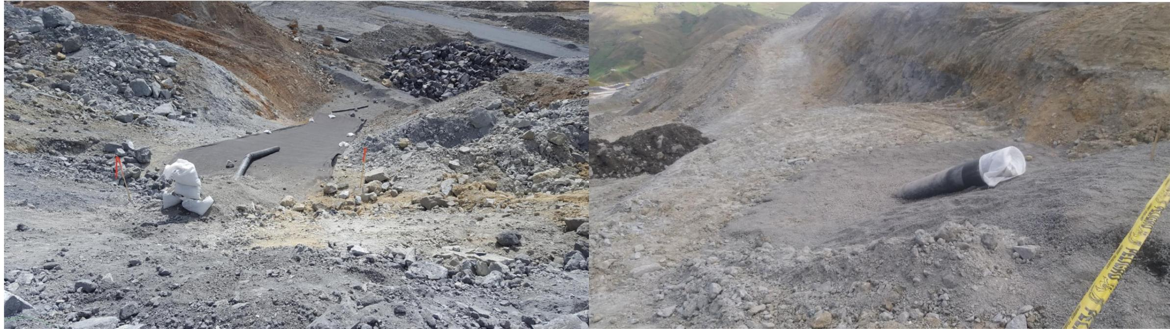
Figura 109 Construcción y relleno del sistema de drenaje vertical
