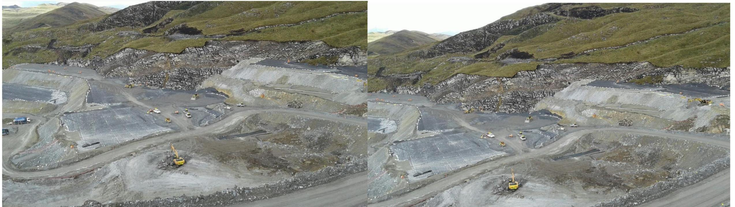
Figura 125 Rellenos, nivelación y revestimientos en zonas intermedias
