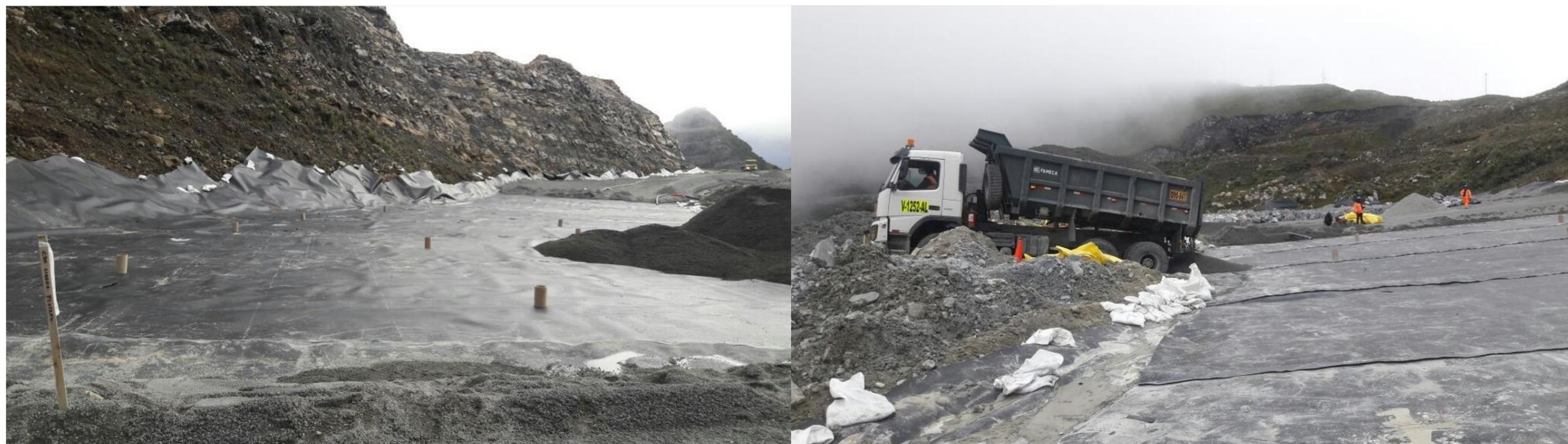
Figura 106 Revestimiento con geosintéticos y rellenos con material filtro
