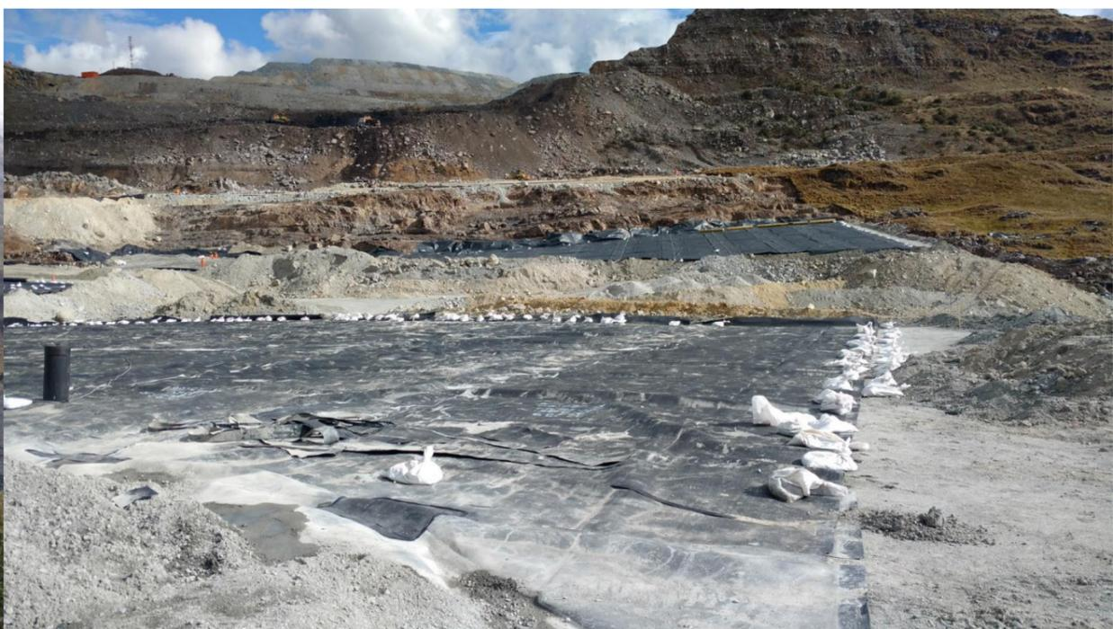
Figura 131 Trabajos de empalmes en la poza se sedimentación
