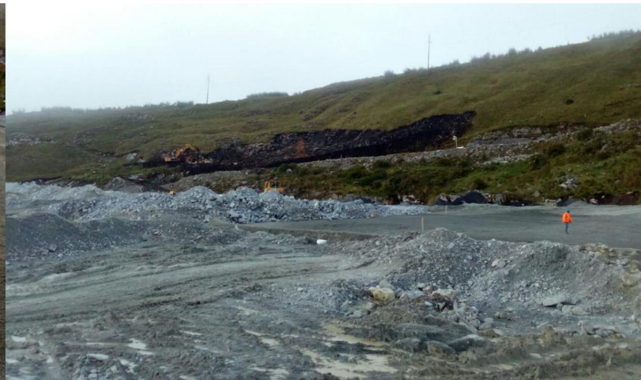
Figura 107 Construcción de camellones y filtros en la zona alta
