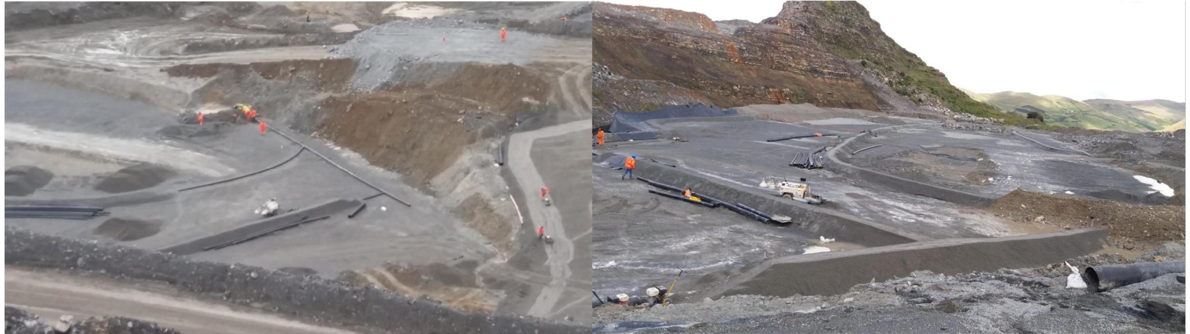
Figura 103 Construcción del sistema Basal para relleno de los shingles
