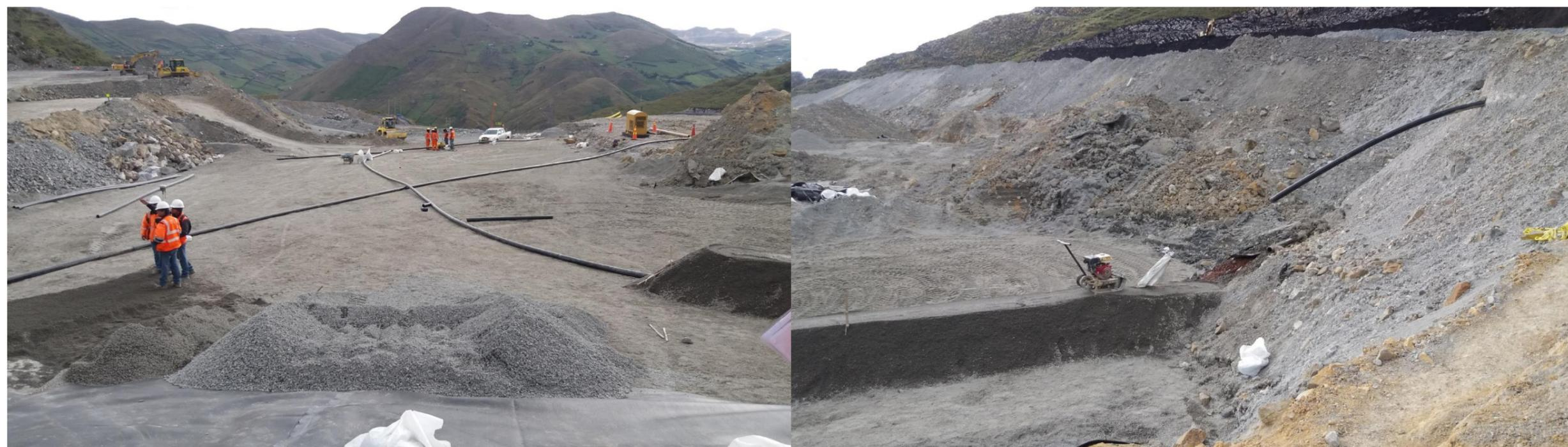
Figura 112 Conexión del sistema de drenaje horizontal y vertical
