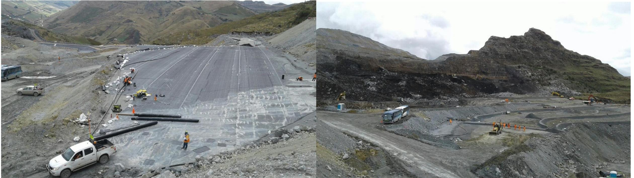
Figura 123 Trabajos de revestimiento en shingles intermedios y accesos
