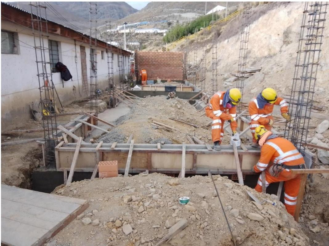
Fotografía 18: Encofrado de sobrecimientos en Pabellón 14-2
