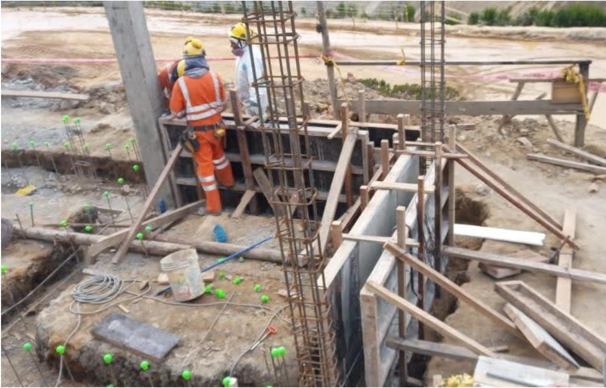
Fotografía 07: Encofrado de sobrecimientos en Pabellón 21
