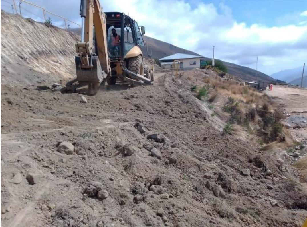
Fotografía 01: Excavación masiva para fundación de Pabellón 21
