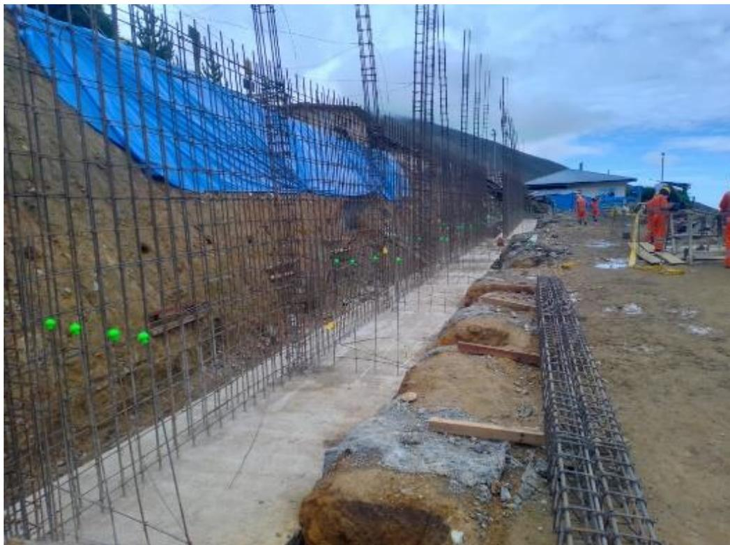
Fotografía 04: Armado de acero en muro de contención Pabellón 21
