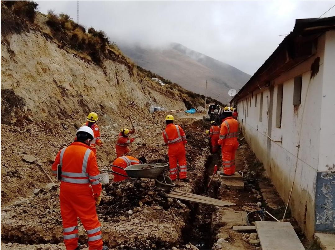
Fotografía 17: Excavación de cimientos en Pabellón 14-2
