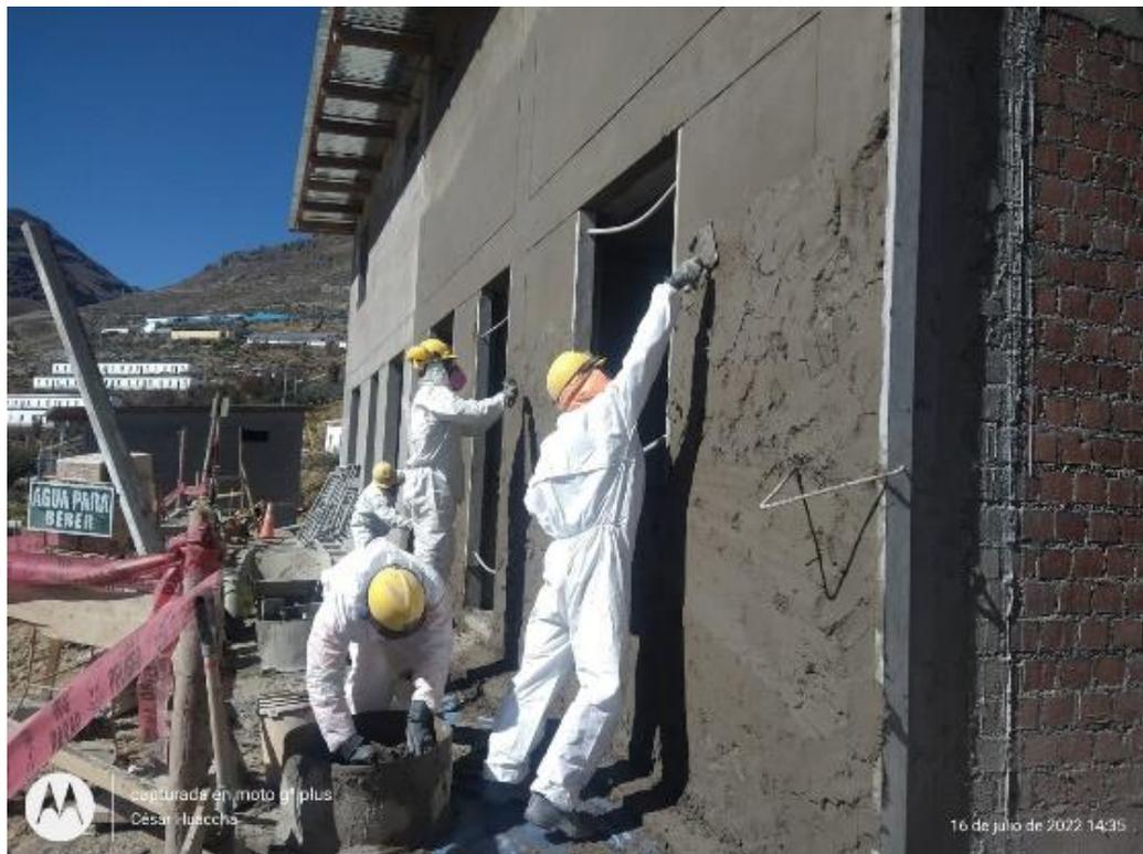
Fotografía 12: Tarrajeo de muros exteriores en Pabellón 21
