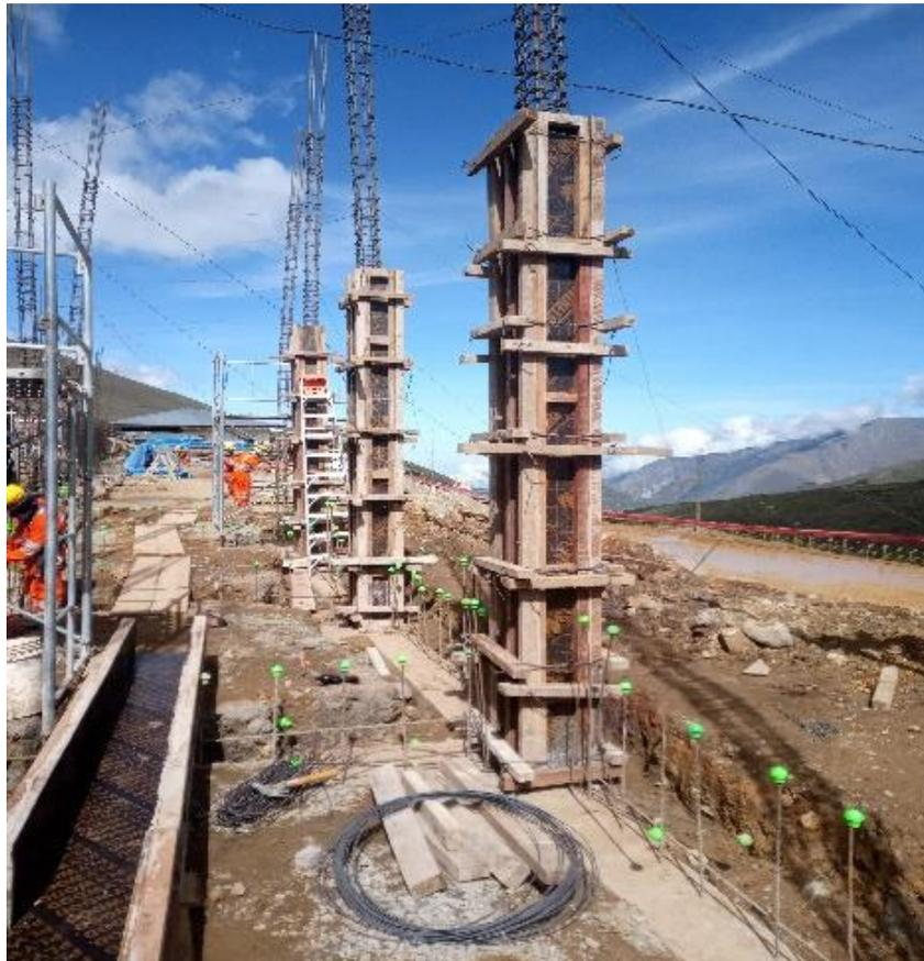
Fotografía 08: Encofrado de columnas en Pabellón 21
