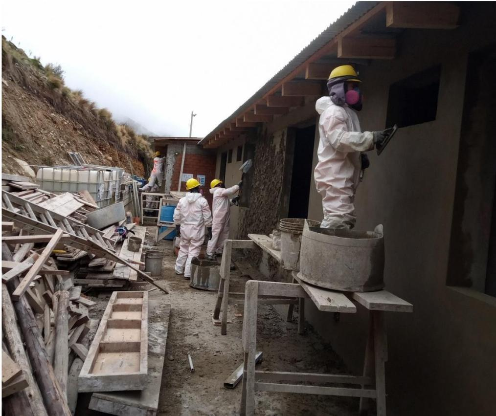
Fotografía 20: Tarrajeo de muros exteriores en Pabellón 14-2
