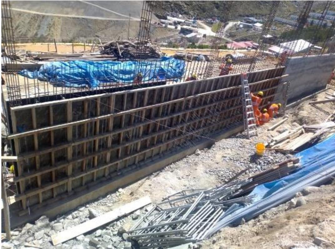
Fotografía 05: Encofrado de muro de contención en Pabellón 21
