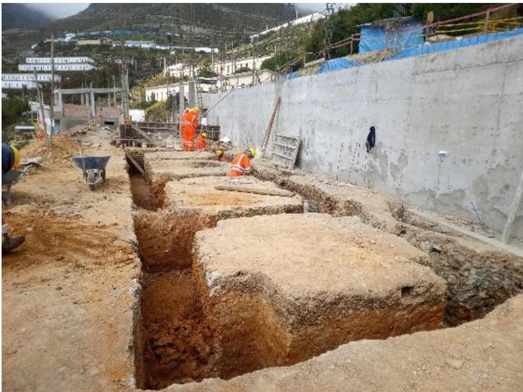
Fotografía 06: Excavación de cimientos para Pabellón 21
