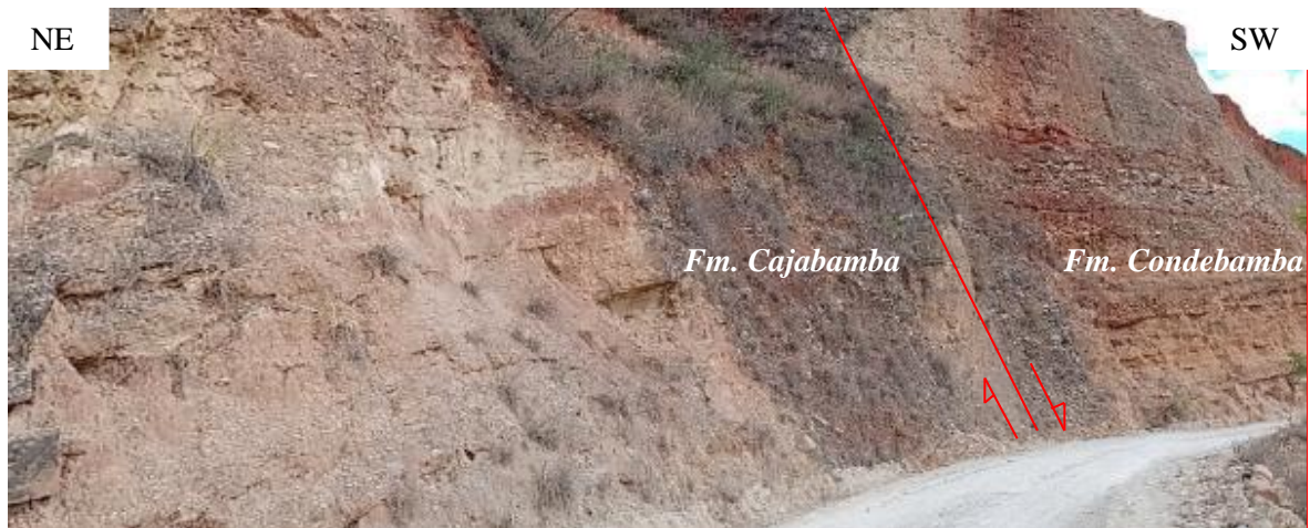
Foto 13. Falla Normal, con dirección NW- SE. 817797- E, 9188690- N.
