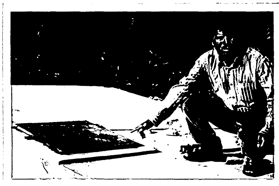
Foto N° 04. Captación del sistema donde se observa el buen estado de la estructura de la captación así como que cuenta con tapa sanitaria así como con el seguro.
