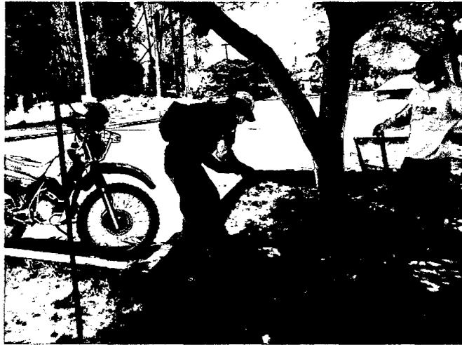
**FOTO 15: Inspección de buzón el cual se encuentra a un costado de un árbol (ubicación inadecuada).**
