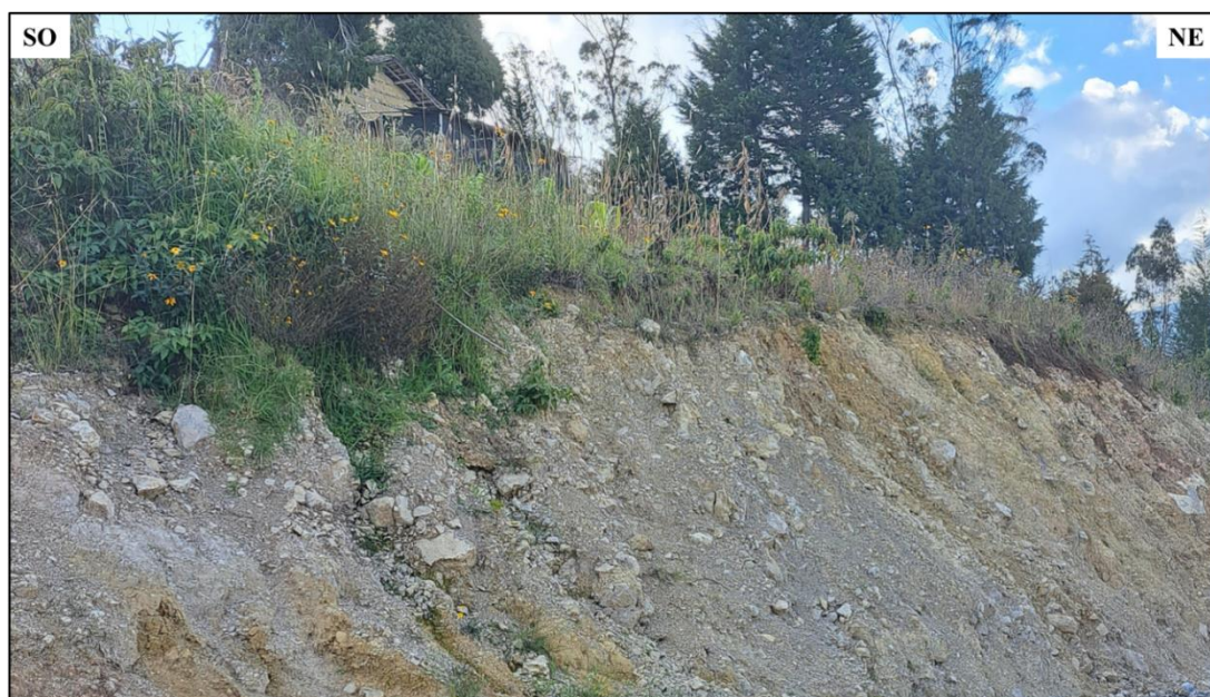
Foto 7. Depósitos coluvio - aluviales en el talud de la trocha carrozable al Centro Poblado Frutillo Bajo (Este: 772671, Norte: 9259490).
