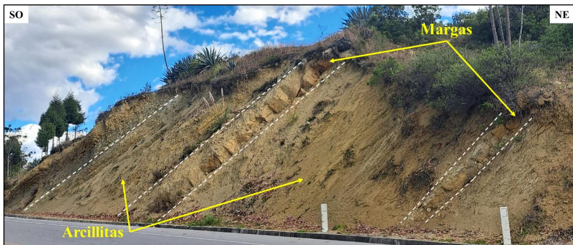
Foto 4. Intercalación de margas y arcillitas altamente meteorizadas de la Formación Celendín. (Este: 772432, Norte: 9260368). Ver Descripción macroscópica en la Tablas 11 y 12.
