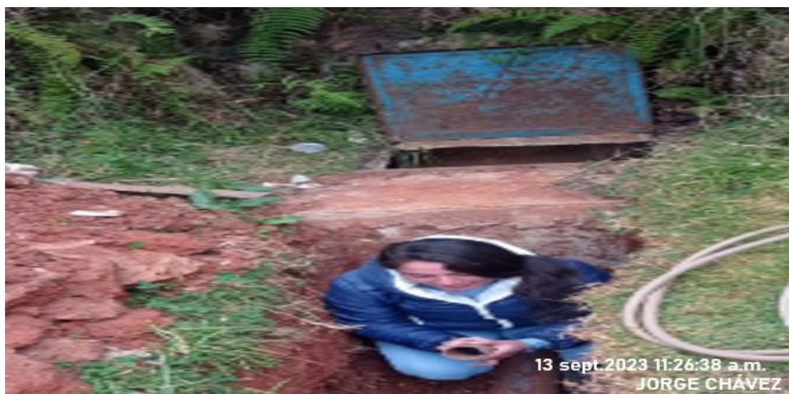
Figura 33 Inspección en la tubería de distribución
