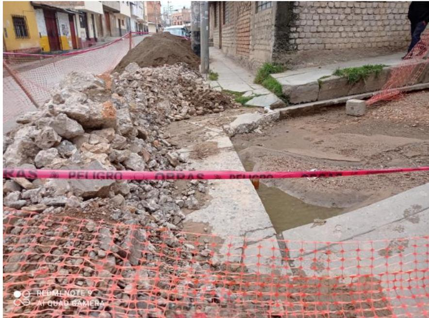
Foto 3: Recolectando el material reciclado de rotura de pistas y veredas
