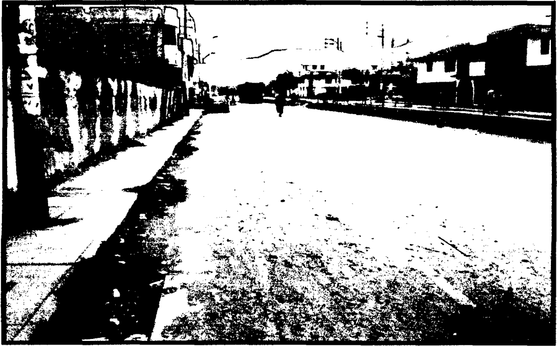
Foto N° 17. Cunetas colmatas de material orgánico e inorgánico reduciendo su funcionalidad (av. Nuevo Cajamarca).
