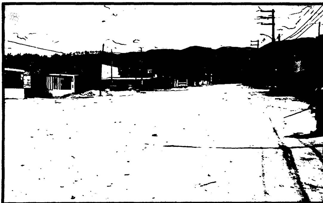
Foto N° 14. Av. Industrial sin pavimentar.
