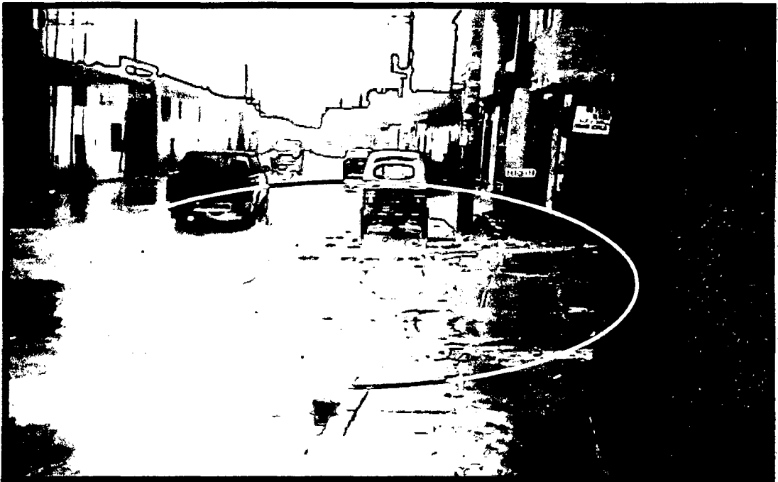
FotoN°18. El funcionamiento del drenaje no cumple según lo que se esperaba, se evidencia desborde del agua drenada al pavimento (av. La Paz).
