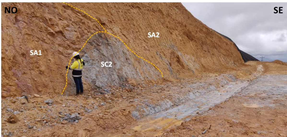
Foto 1. Dominios Geotécnicos en el banco 4000 de la Pared Norte del Tajo Quecher Main. Se observa que el dominio geotécnico Sílice Alunita 1 (SA1) se presenta en bloques asociado al dominio geotécnico de menor resistencia de Sílice Alunita 2 (SA2), con núcleos de rocas con mayor cantidad de arcillas en tonos grises pertenecientes al dominio geotécnico Sílice Clay 2 (SC2).
