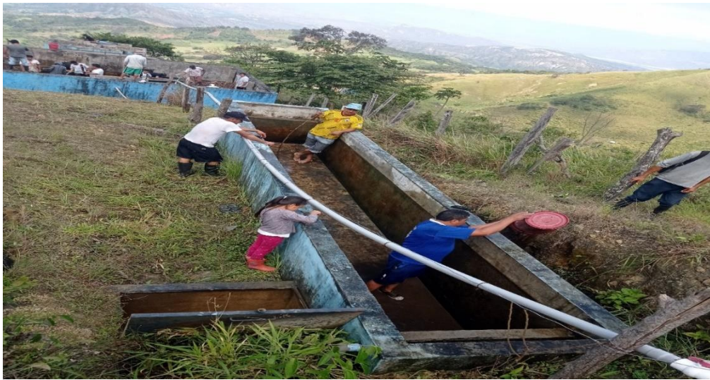
Foto 28: Limpieza de los componentes del sistema de agua
