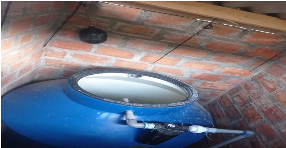
Foto 21: Válvula de control sin protección
