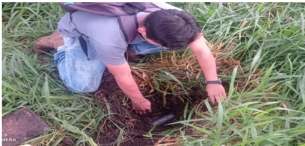
Foto 32: Verificación de diámetros de tubería
