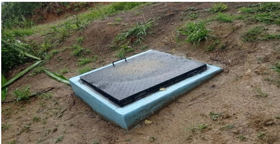
Foto 8: Planta de Tratamiento de Agua Potable
