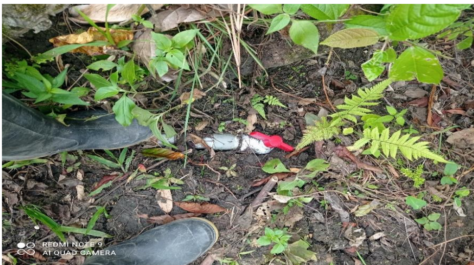
Foto 21: Válvula de control sin protección
