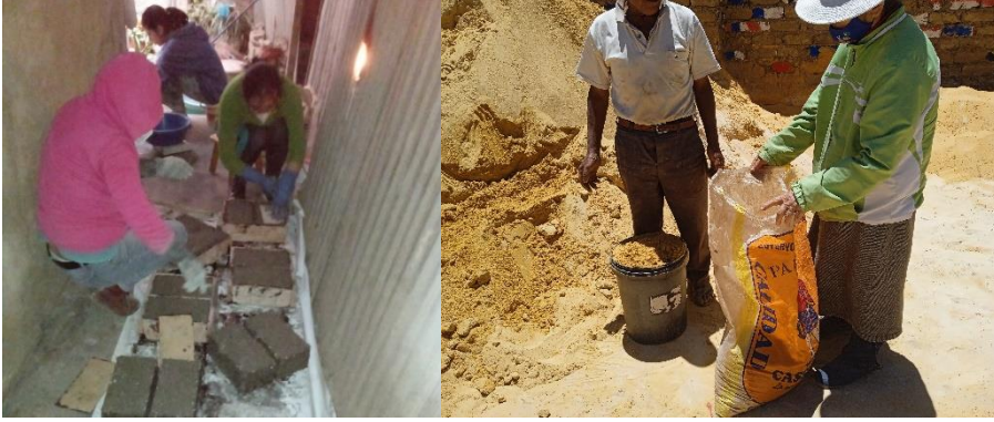
Figura 21: Elaboración de ladrillos PET y cemento.
