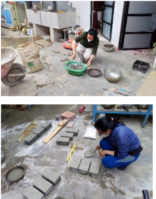
Figura 16: Elaboración de ladrillos de PET y cemento y refrentado de ladrillos.
