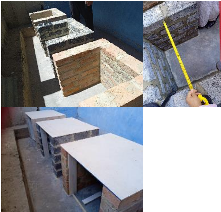
Figura 28: Construcción de tres módulos de 50cmx50cmx50cm de materiales ladrillos PET y cemento, ladrillo de arcilla y ladrillo de concreto artesanal, los techos de drywall y las puertas de melanina (medidas idénticas para los tres módulos).
