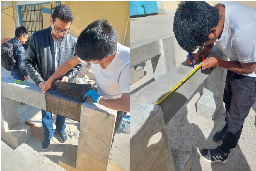
Fotografía N°18. Verificación de medidas y traslape de fibra de carbono
