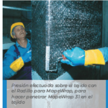
Extensión de MapeWrap 31 con rodillo, sobre una capa de MapeWrap 11 (o MapeWrap 12) aún fresca
