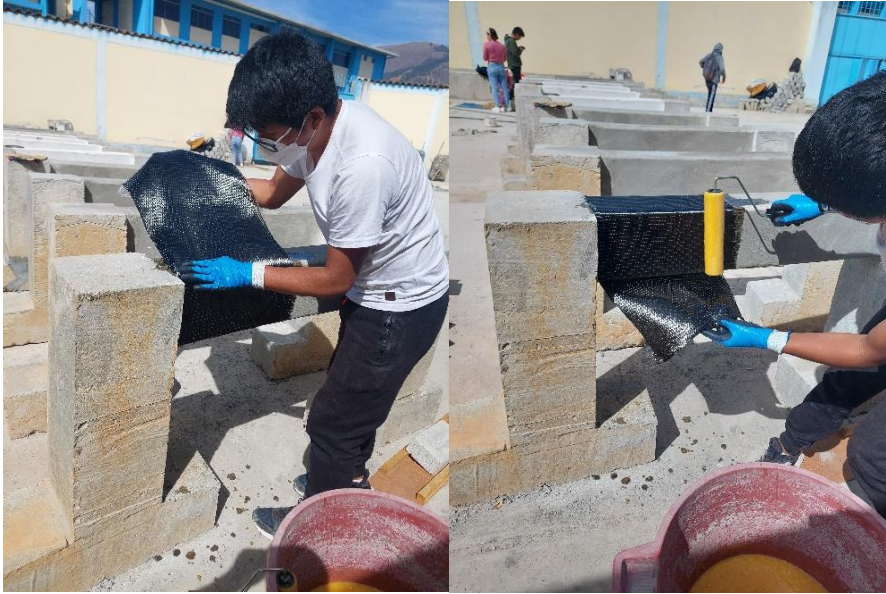
Fotografía N°23. Colocación de la fibra de carbono y aplicación de MapeWrap 31 en traslape de 20 cm
