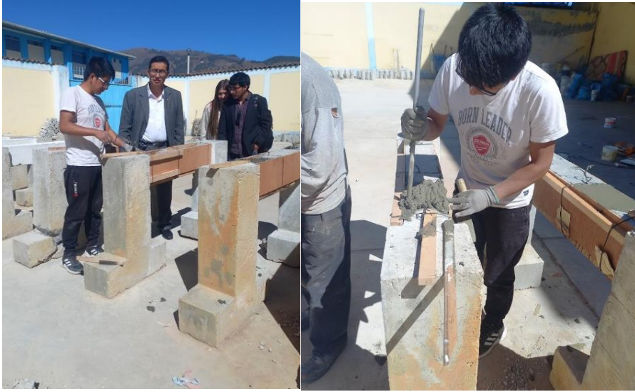
Fotografía N°09. Colocación del mortero en la reparación de vigas
