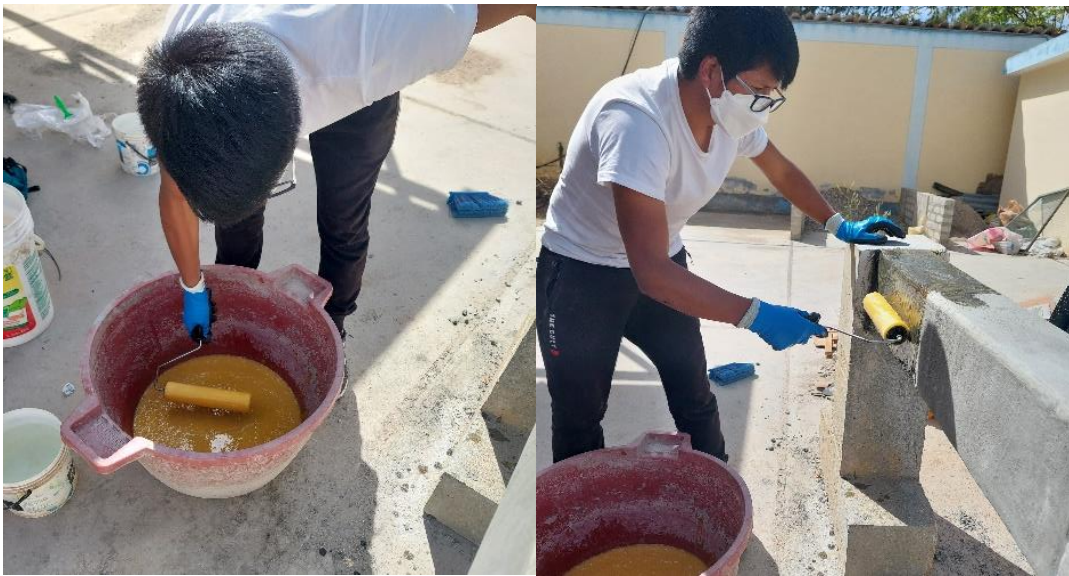
Fotografía N°22. Aplicación de MapeWrap 31 sobre la capa de MapeWrap Primer 1
