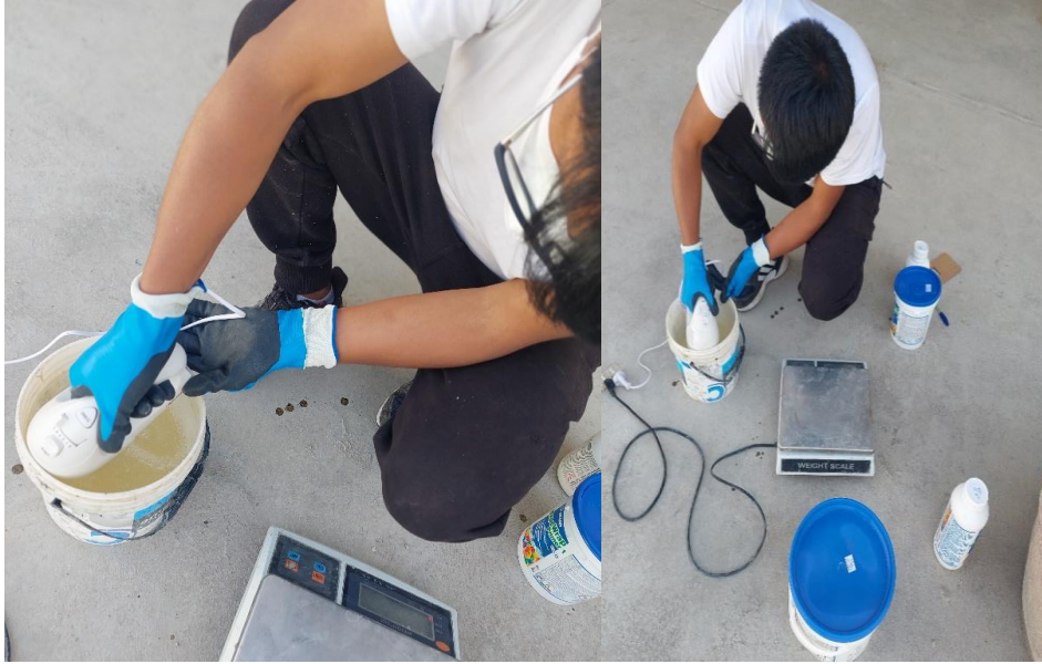
Fotografía N°19. Preparación del producto MapeWrap Primer 1
