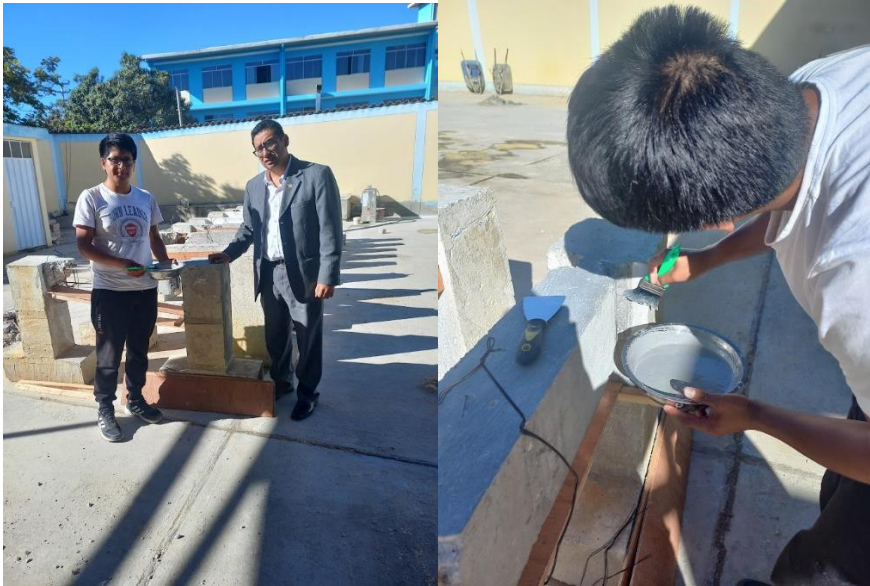
Fotografía N°05. Aplicación de puente adherente (Sikadur 32), considerando el tiempo de trabajabilidad según su hoja técnica.
