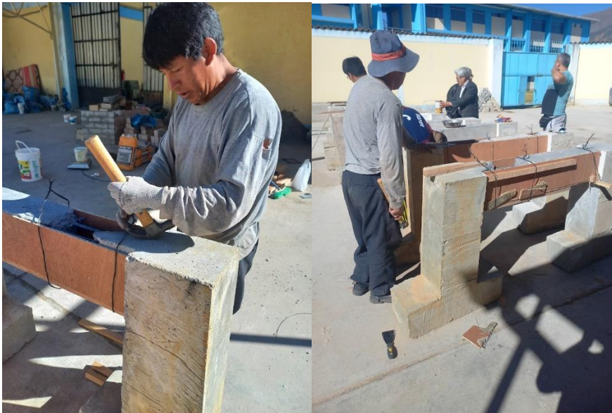
Fotografía N°06. Encofrado de vigas para colocación de SikaRep 500
