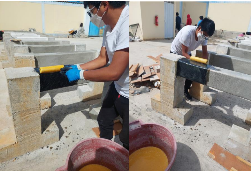
Fotografía N°24. Aplicación de la segunda capa de MapeWrap 31 sobre la fibra de carbono
