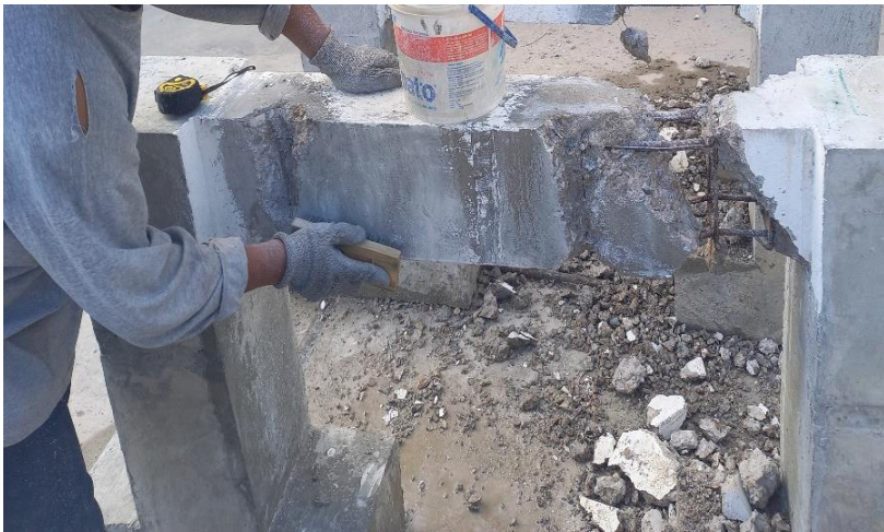
Fotografía N°04. Retiro de pintura y limpieza de concreto
