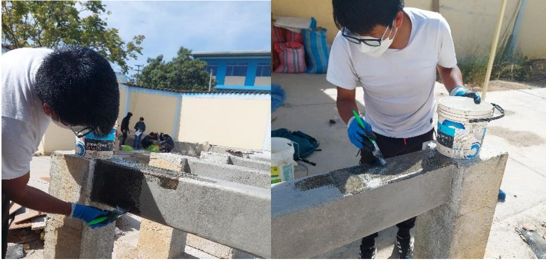
Fotografía N°21. Aplicación de la capa inicial – MapeWrap Primer 1
