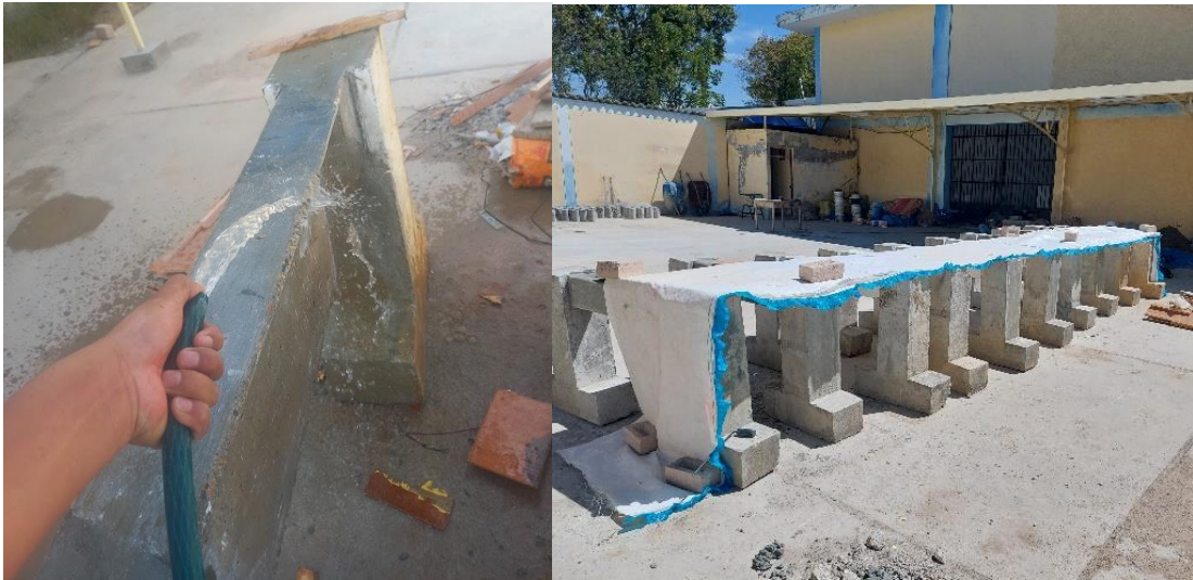
Fotografía N°14. Proceso de curado de pórticos
