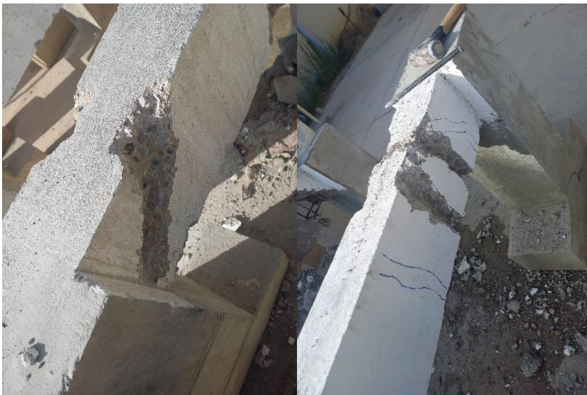
Fotografía N°02. Picado de fisuras, para su posterior reparación
