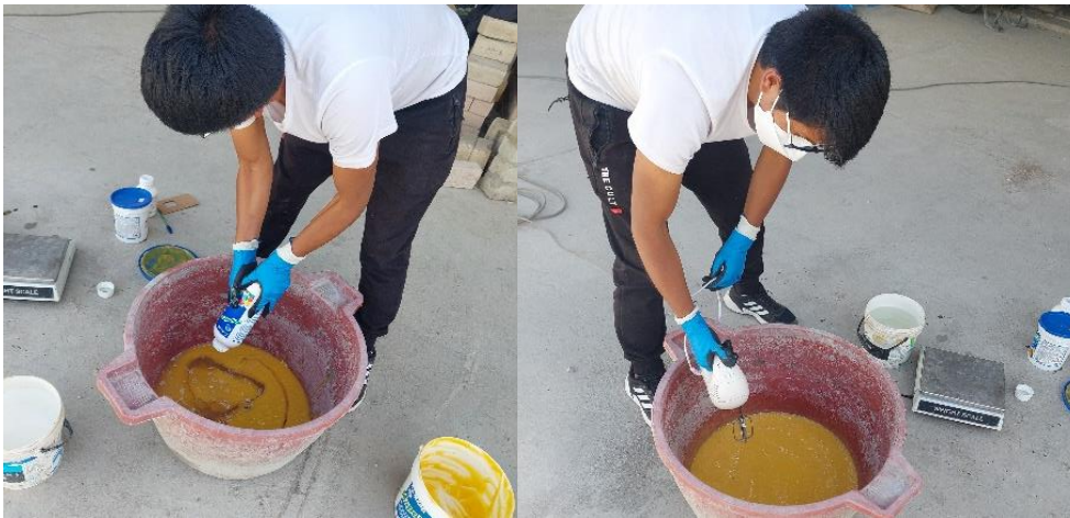
Fotografía N°20. Preparación del producto MapeWrap 31
