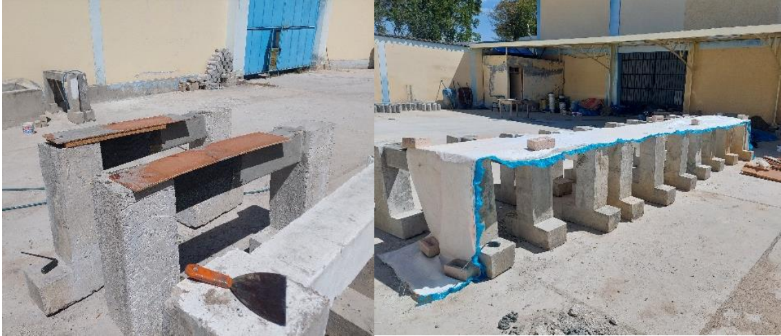
Fotografía N°27. Culminados los trabajos de reforzamiento, se dejó protegido las estructuras por 14 días hasta su ensayo a corte
