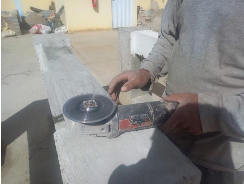
Fotografía N°15. Retirado el encofrado, se eliminó los vértices y salientes con ayuda de una amoladora
