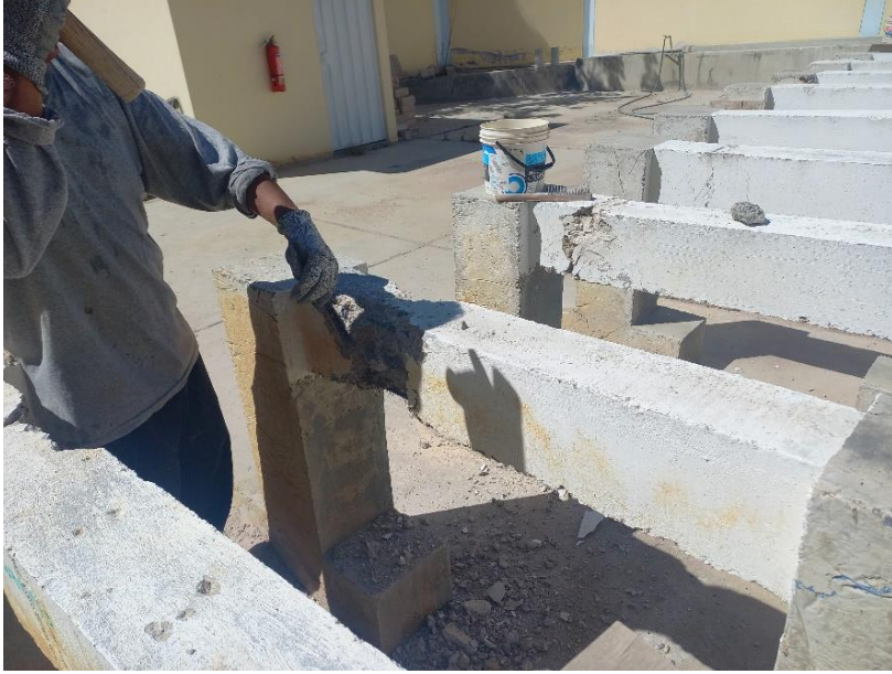
Fotografía N°03. Remoción de daños severos de concreto
