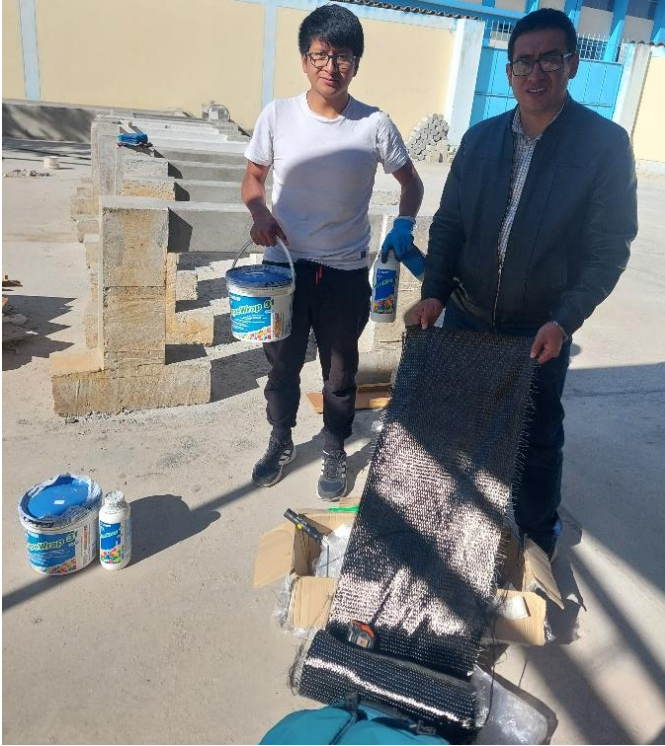
Fotografía N°17. Verificación de tela de fibra de carbono e imprimantes
