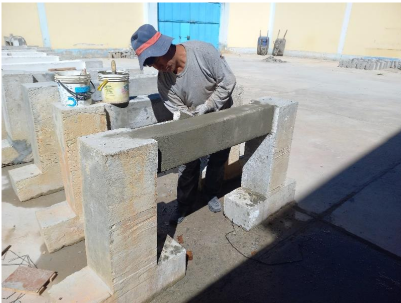
Fotografía N°16. Reparación de pequeñas cavidades (solaqueo) con cemento portland tipo 1
