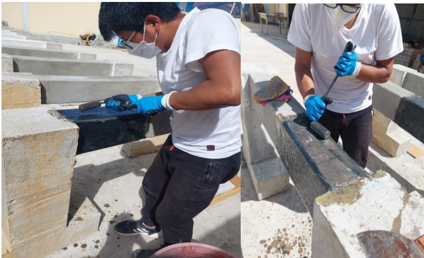
Fotografía N°26. Con un rodillo con tornillo sin fin de aluminio, eliminamos completamente las burbujas de aire, el rodillo se pasa solamente en la dirección de las fibras primarias de la tela
