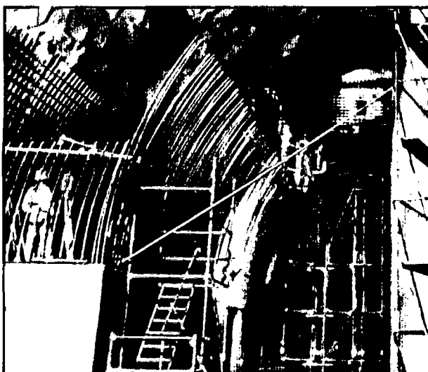
Colocación de Encofrado Curvo
