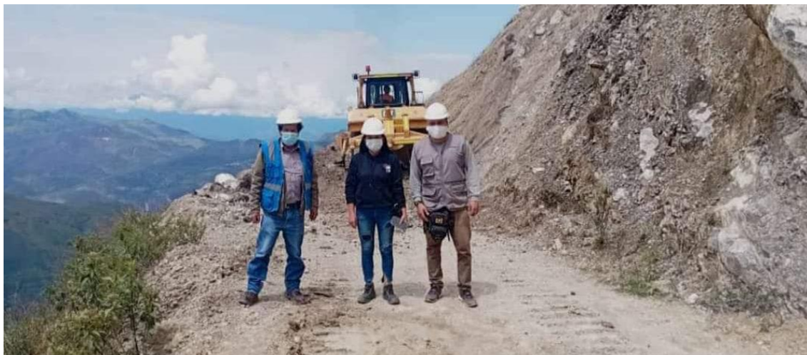
Fotografía 2. Realización de tareas de excavación por parte de la maquinaria
