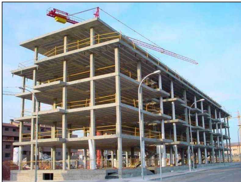
Figura 1. Edificio de concreto armado en construcción.
