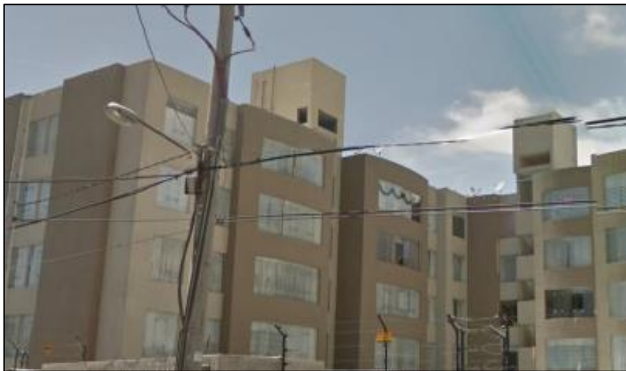
Figura 6. Edificios con tanques elevados unidos a su estructura.
