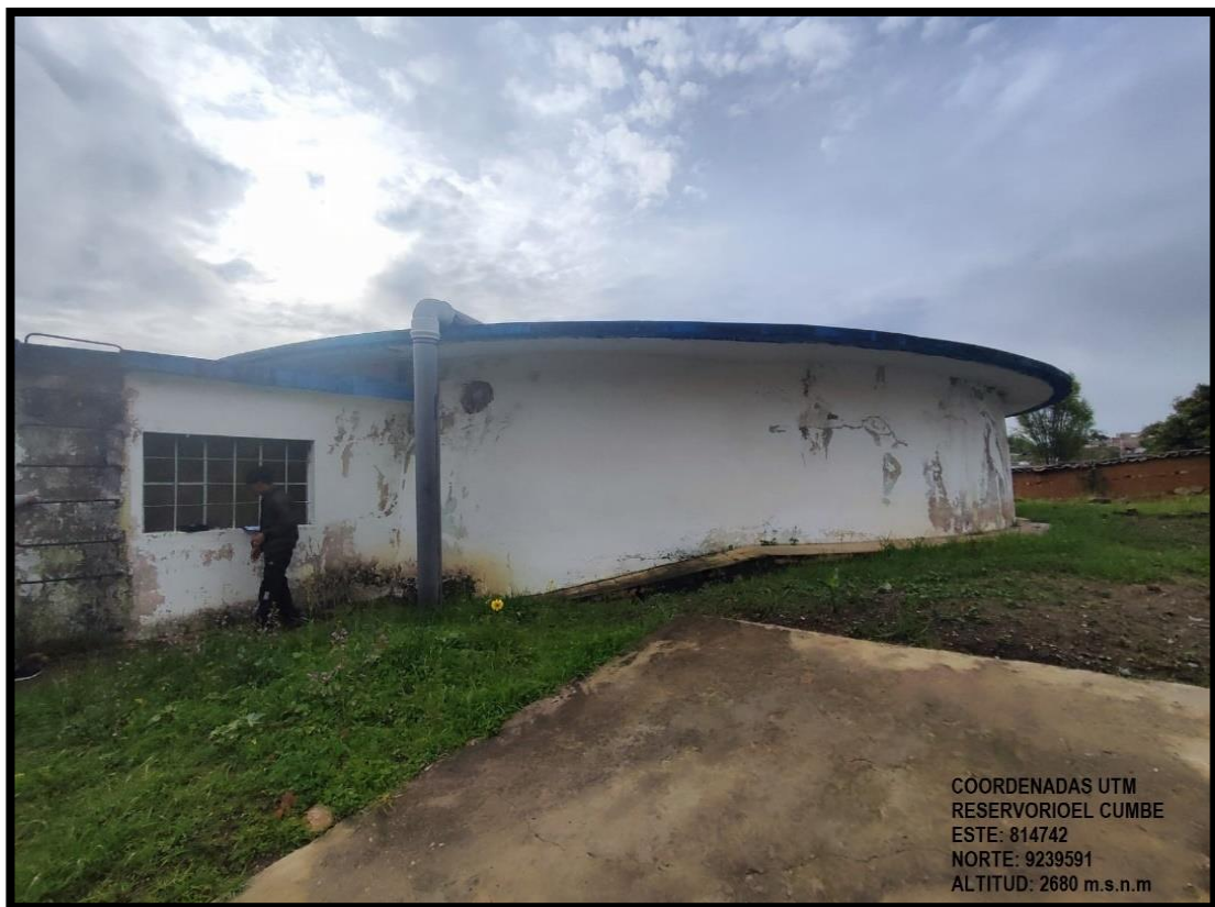
Figura N° 22. Reservorio de agua El Cumbe.
