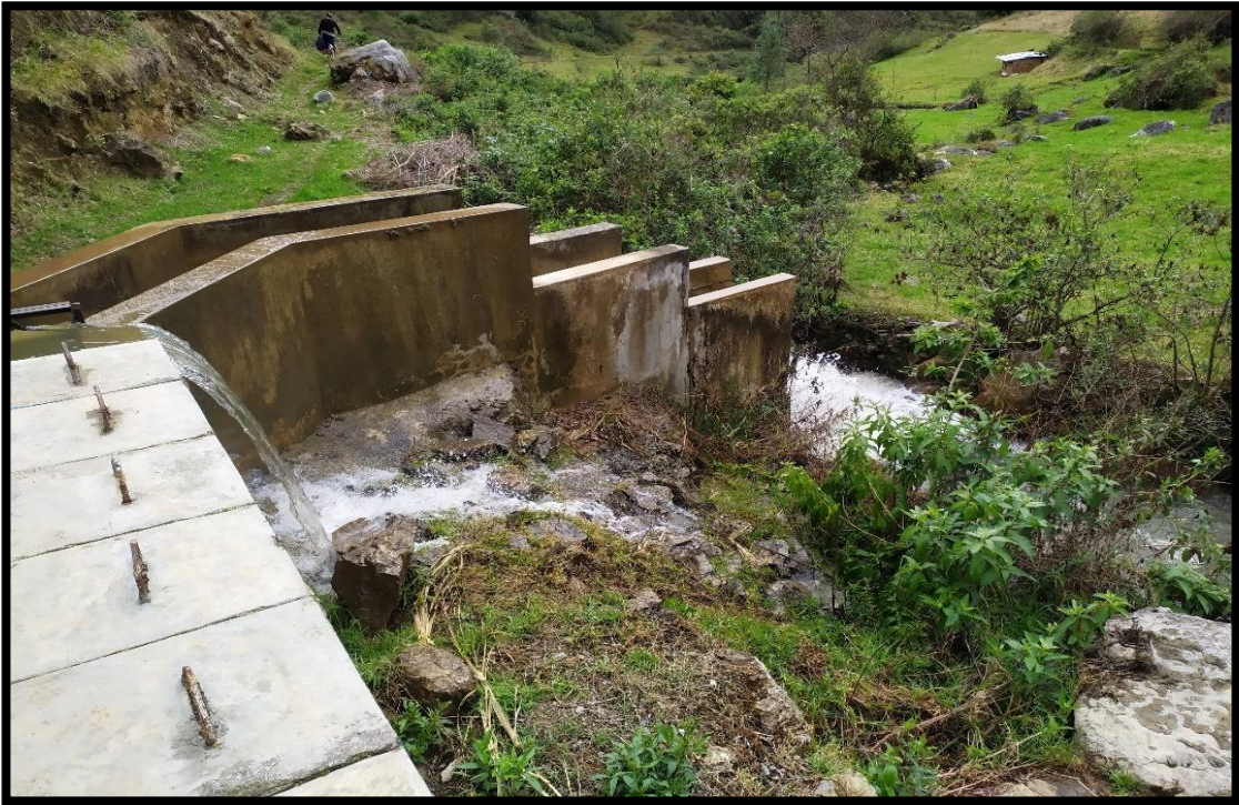
Figura N°16. Canal aliviadero que va al rio.
