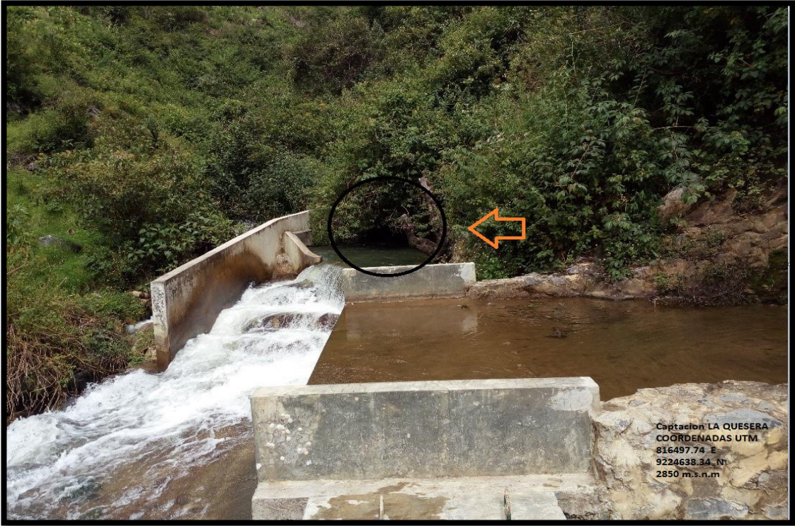
Figura N°16. Canal aliviadero que va al rio.
