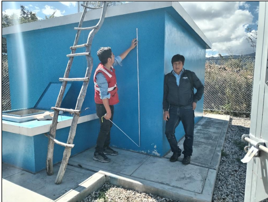
Foto 4: Reservorio rectangular de concreto armado
