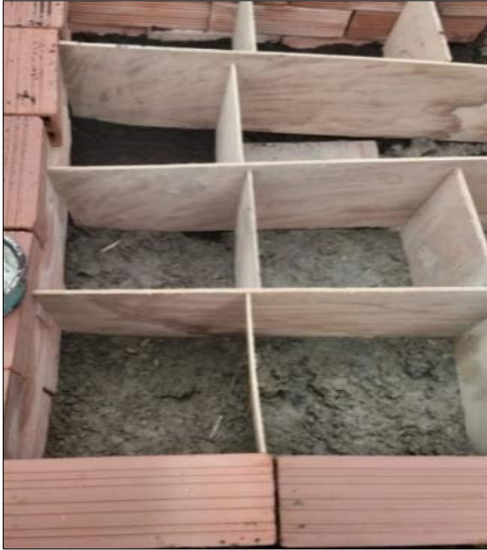
Foto 11. Acondicionamiento del área e instalación del germinador.
