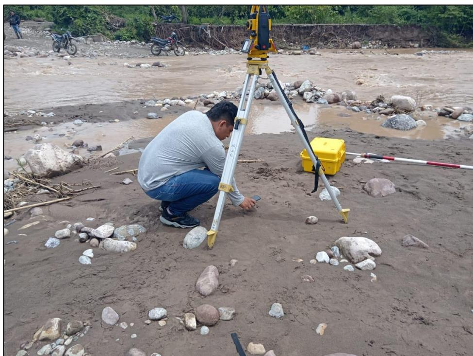
*Figura N°41. Toma de coordenadas BM para levantamiento topográfico.*
