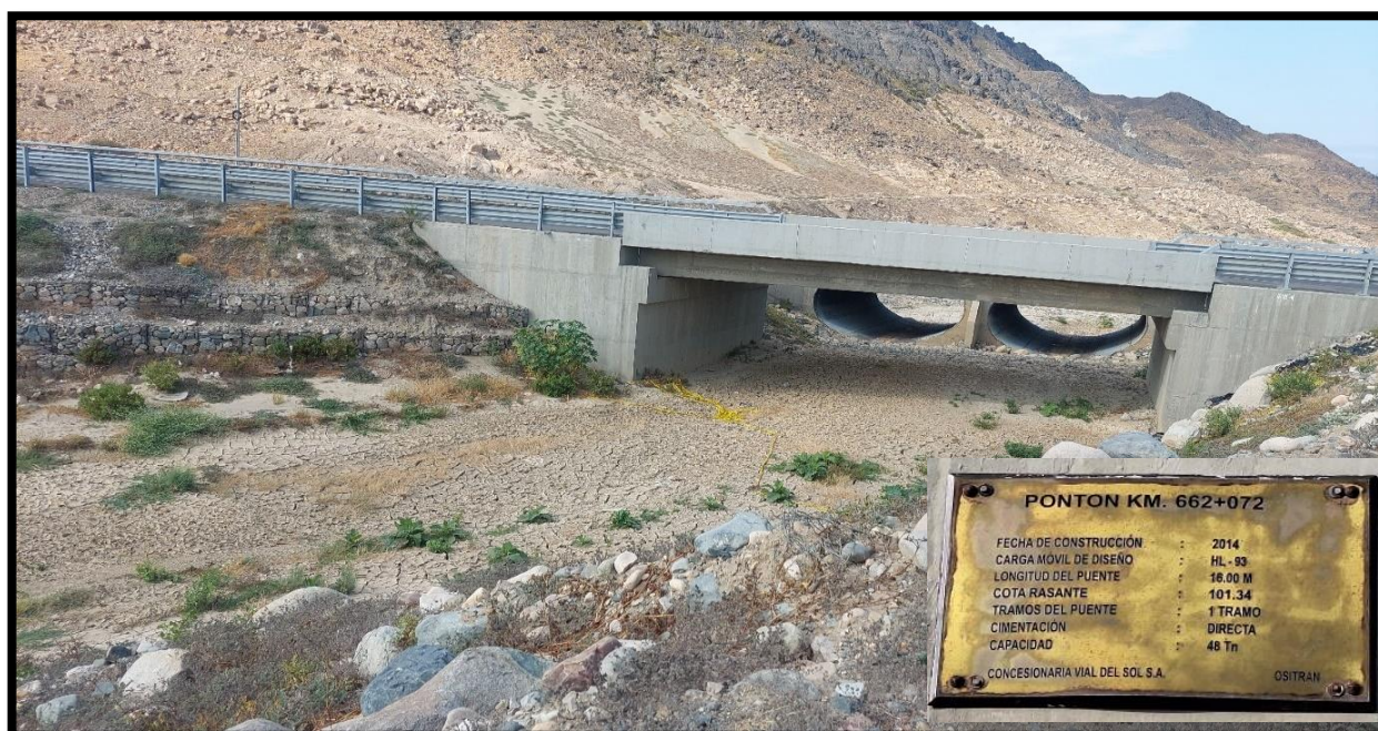
Figura.N°12: Vista frontal del Pontón del KM 662 + 072
