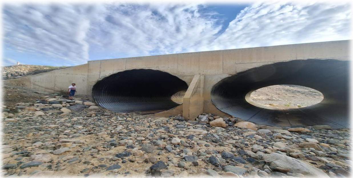
Toma de medidas de las estructuras por donde circula el Rio chilco – (Pontón y alcantarillas)
