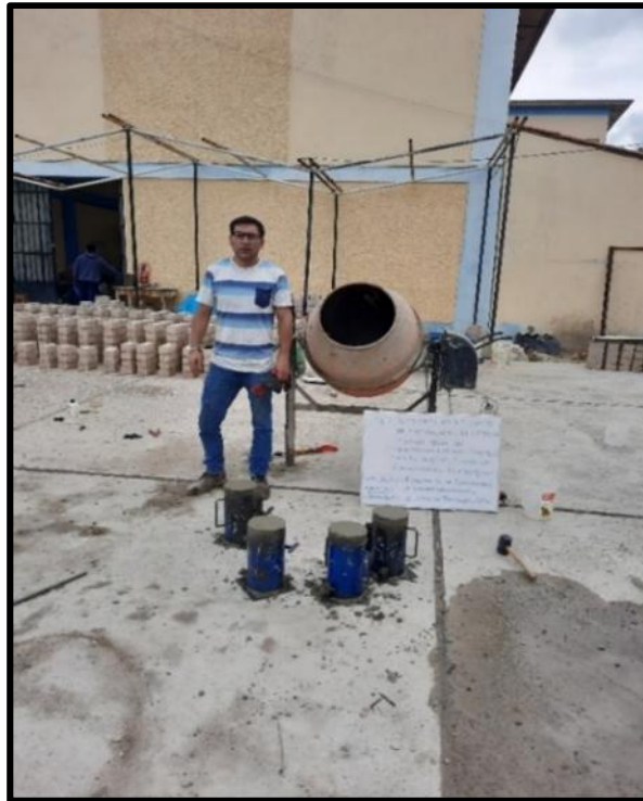
Foto.N°11. Elaboración del concreto convencional f'c = 210 \text{ kg/cm}^2 , así mismo se muestra el llenado de los moldes.
