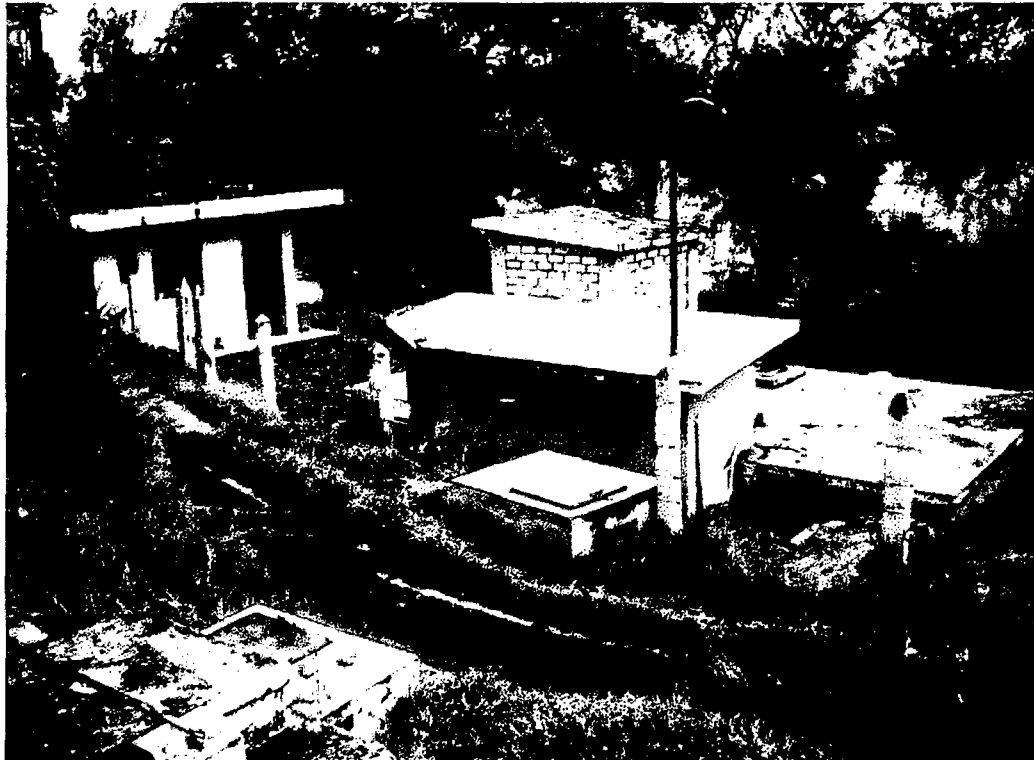
Foto 08: Reservorio por gravedad (vista 01)
