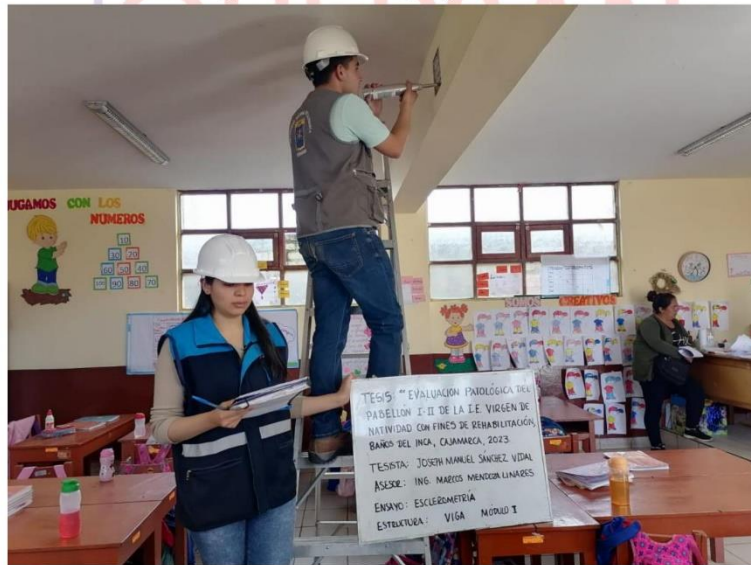
Fotografía N° 2 Ensayo 25, P - I: Viga
