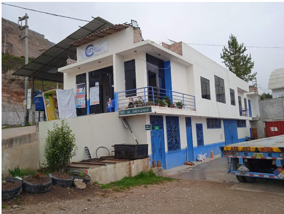
Figura 18 - Vista isométrica del edificio administrativo de la Calera Bendición de Dios E.I.R.L
