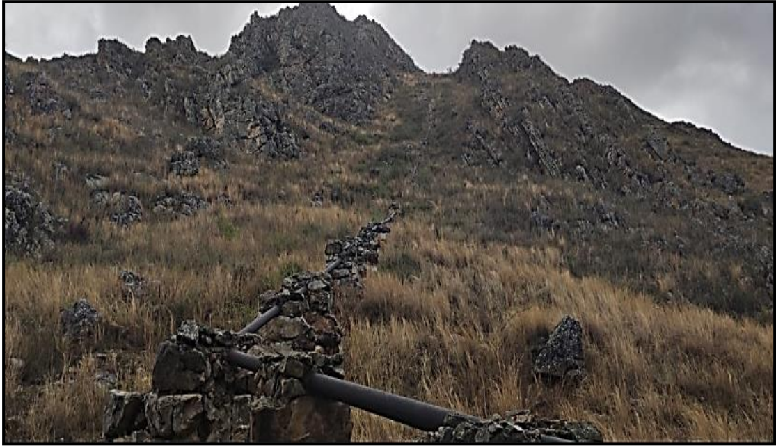
Figura 53: Tubería de impulsión
