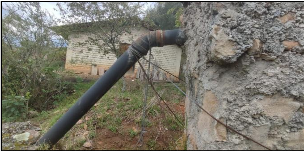
Figura 50: Tubería de impulsión.
