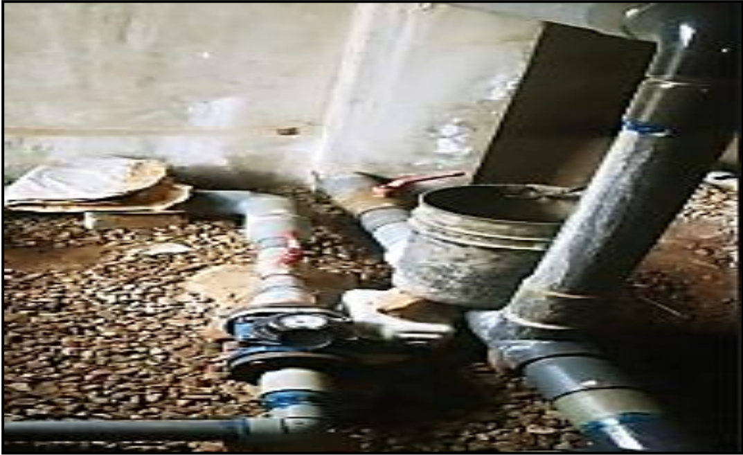
Figura 50: Tubería de impulsión.
