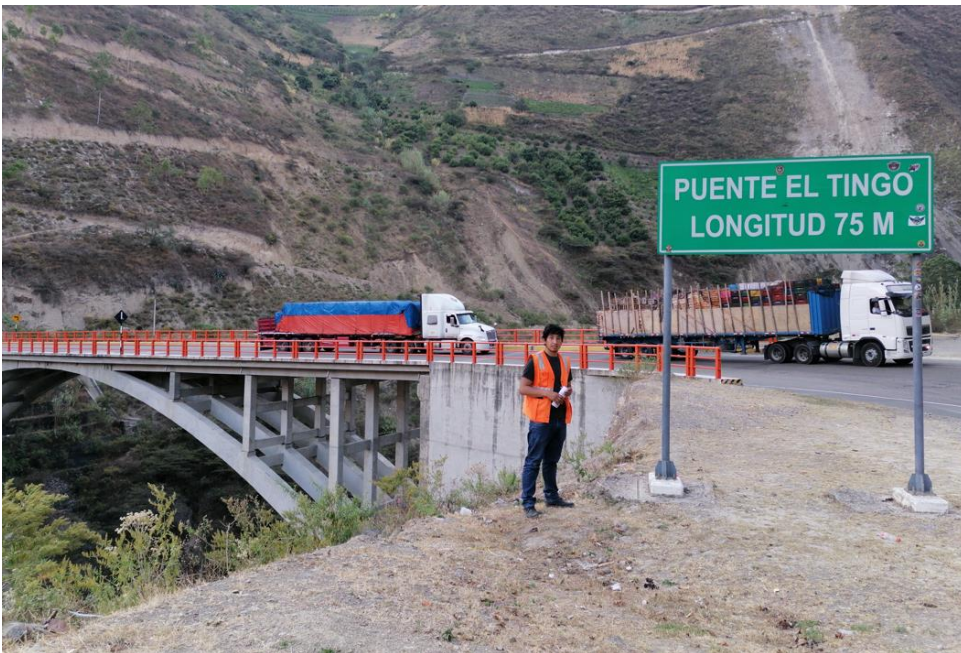
Figura 42: Fotografía de punto inicial del levantamiento topográfico.
