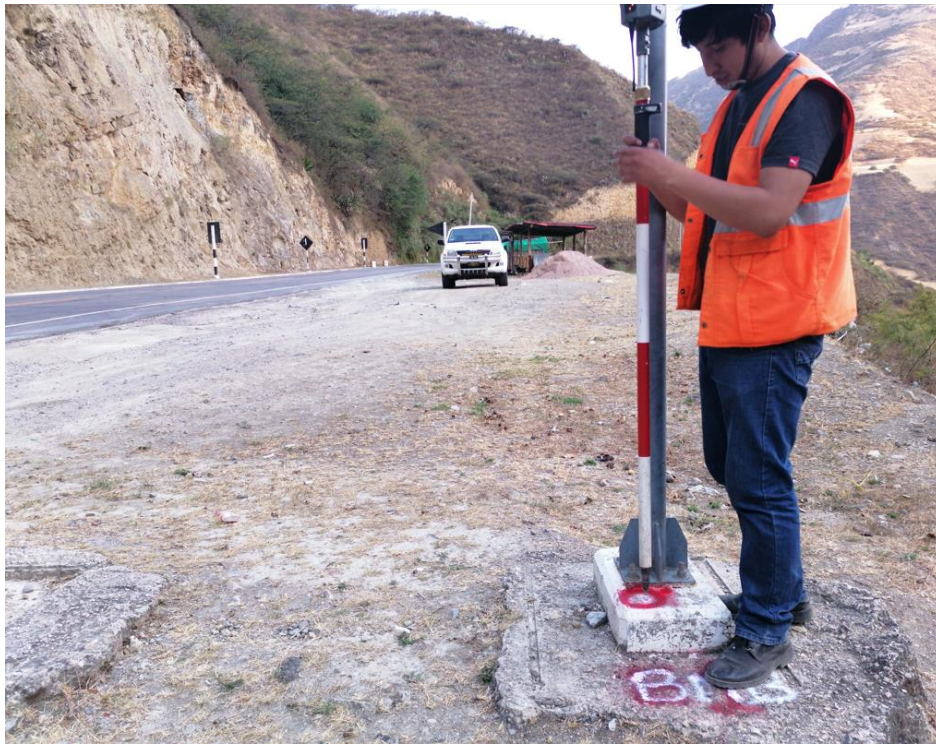
Figura 44: Fotografía del levantamiento de obras de arte.
