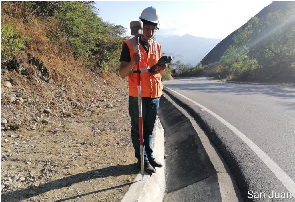
Figura 45: Fotografía del levantamiento de cunetas.
