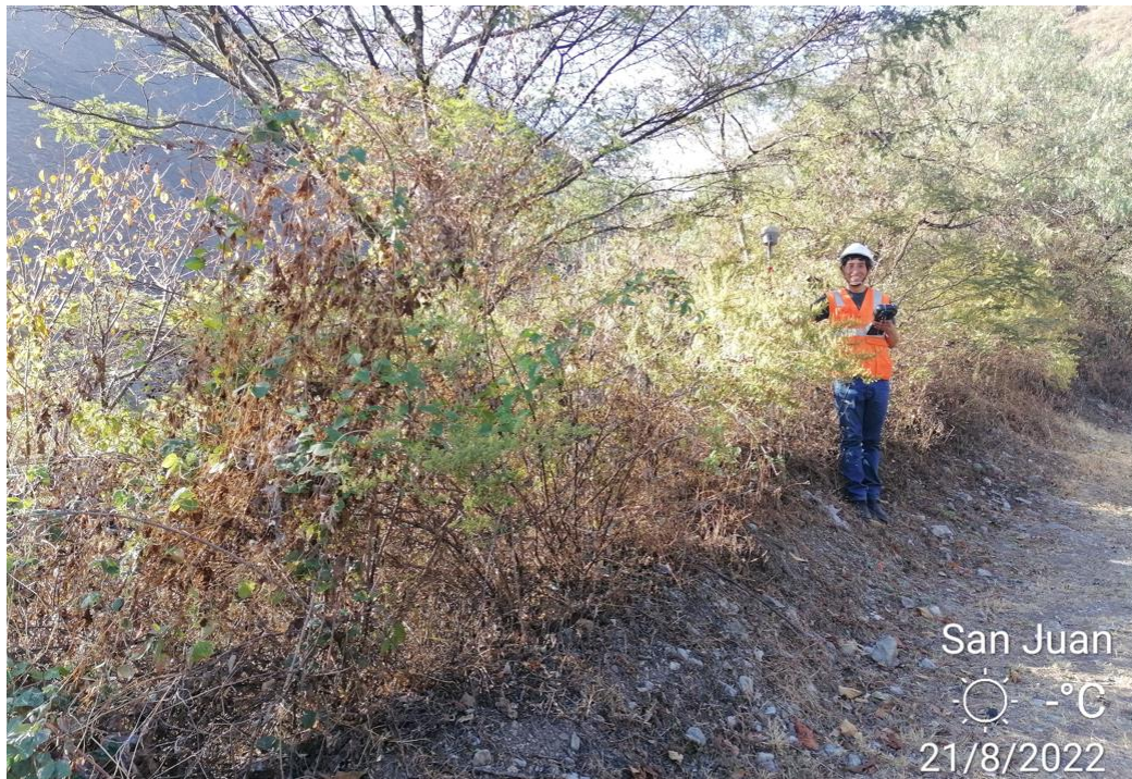
Figura 51: Fotografía del levantamiento de taludes.
