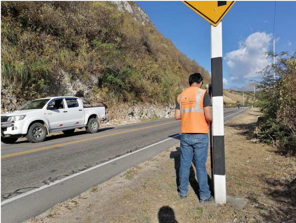
Figura 53: Fotografía del levantamiento de las señalizaciones.
